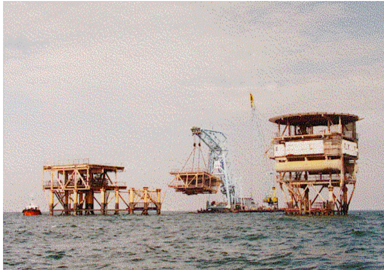
Figura 2.22 - Sollevamento di un Deck
