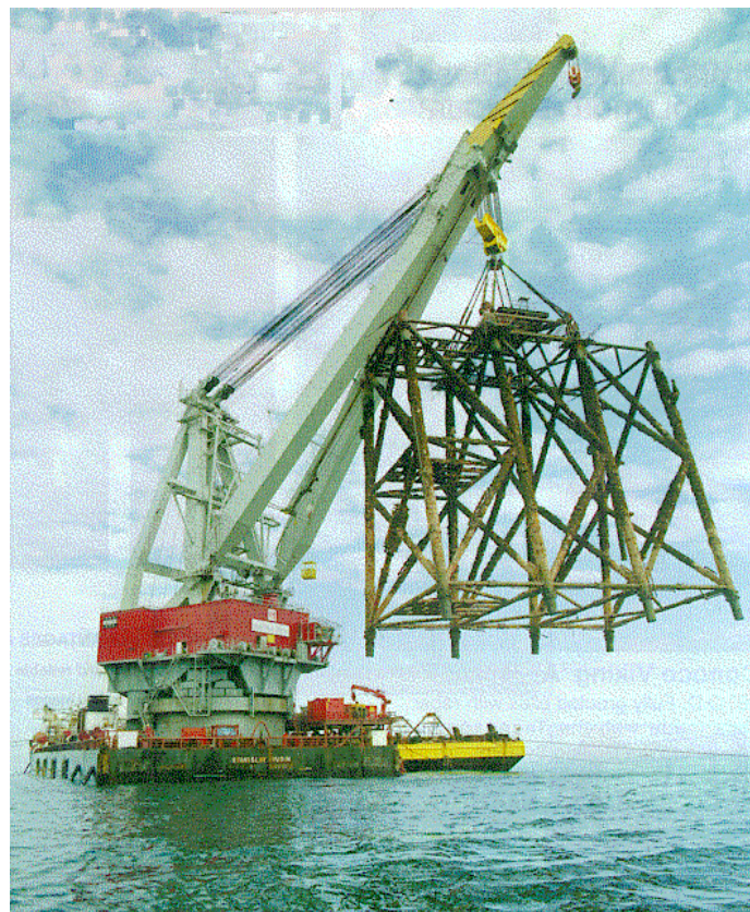
Figura 2.23- Sollevamento Completo di un Jacket
