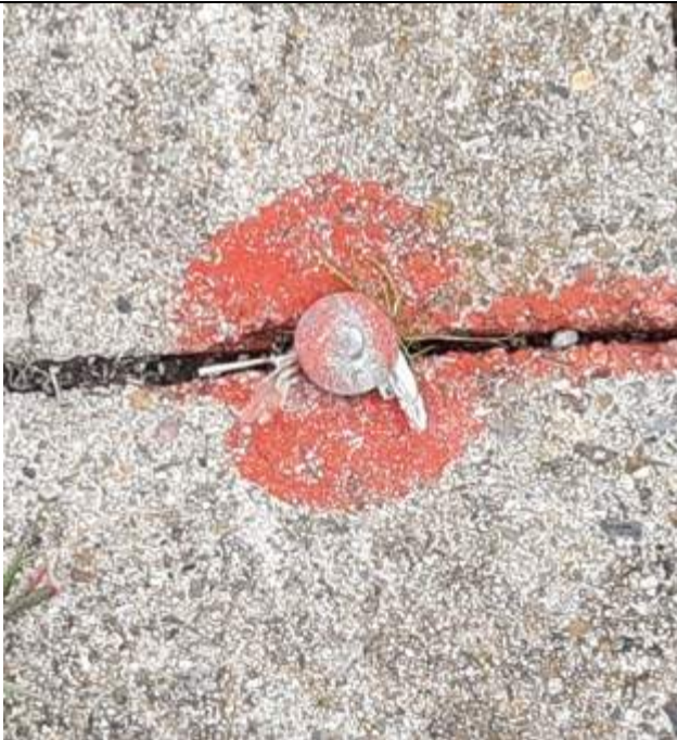
S17-CS3 il caposaldo è nel giunto fra due cordonate
