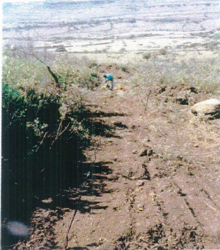
FOTO n° 10 - Panoramica sulla linea a riflessione - lato E - Fase di stendimento dei cavi sismici
