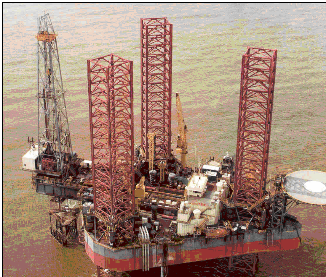
Figura 1.2 – Esempio di Impianto di perforazione (“Jack-up”)
