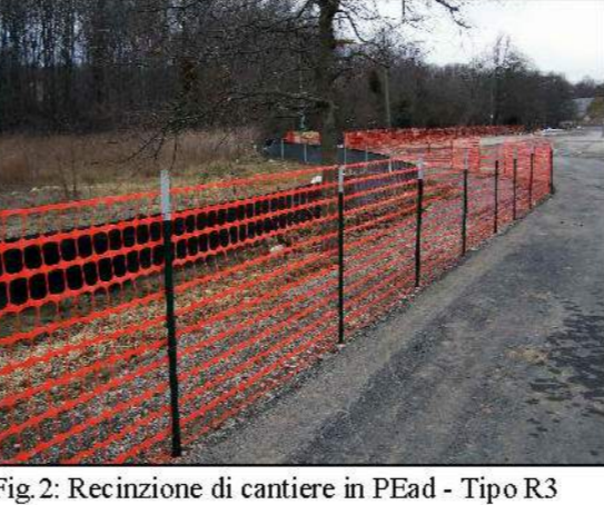
Fig.1: Recinzione metallica di cantiere - Tipo R2 Fig.2: Recinzione di cantiere in PEad - Tipo R3 Fig.3: Bagni chimici di cantiere Fig.4: Impianto lavaggio ruote
