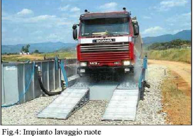
Fig.1: Recinzione metallica di cantiere - Tipo R2 Fig.2: Recinzione di cantiere in PEad - Tipo R3 Fig.3: Bagni chimici di cantiere Fig.4: Impianto lavaggio ruote
