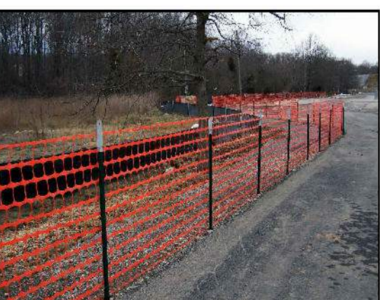
Fig.2: Recinzione di cantiere in PEad - Tipo R3
