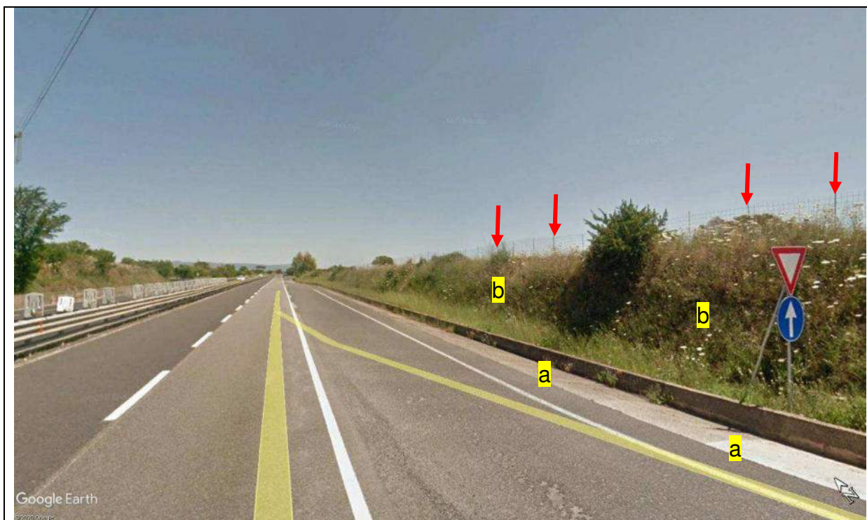
Foto 23c - Rampa di accesso da Nuraghe Losa. Si evidenziano i seguenti elementi: a= cunetta in cls; b= scarpata con arbusti. Le frecce rosse indicano la linea della recinzione sul ciglio della scarpata.
