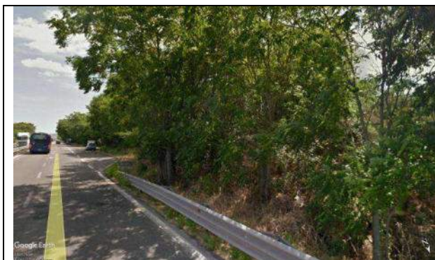
Foto 31a - Panoramica area di intervento lato corsia di decelerazione.
