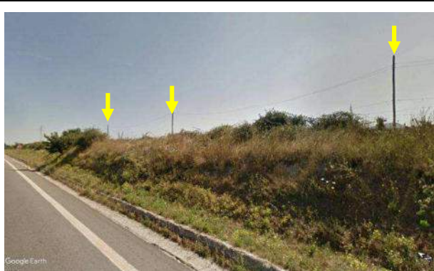
Foto 19a - Le frecce gialle indicano i tralicci in legno della linea telefonica e di TD parallela alla carreggiata nord dir. Sassari interferente con il nuovo svincolo.
