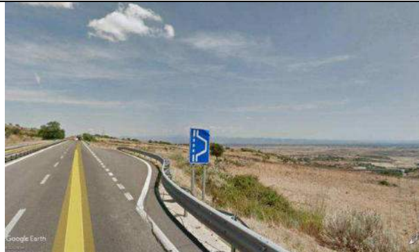
Foto 28d - Panoramica della piazzola di sosta sulla carreggiata sud con il relativo pendio, la segnaletica verticale e le barriere di sicurezza.
