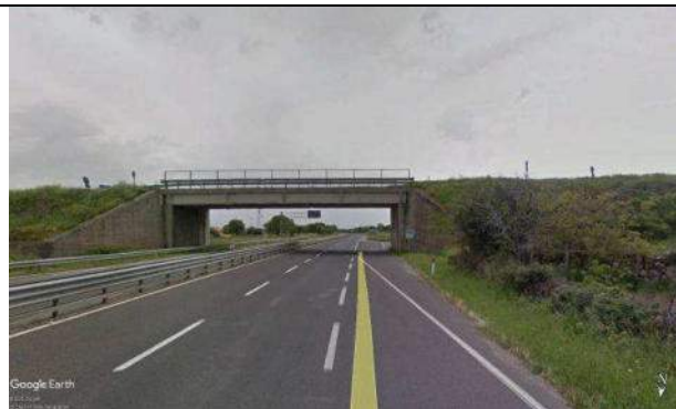
Foto 27a - Panoramica corsia di accelerazione e cavalcavia SP 77
