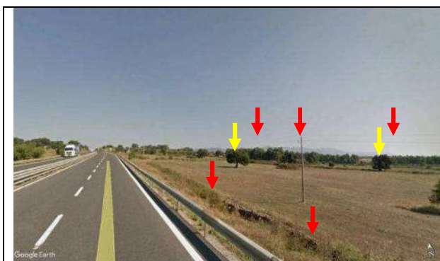
Foto 36c - CN: Panoramica area di intervento; le frecce indicano la rete in MT con i tralicci, i muretti in pietrame e le sporadiche essenze arboree presenti (frecce gialle).
