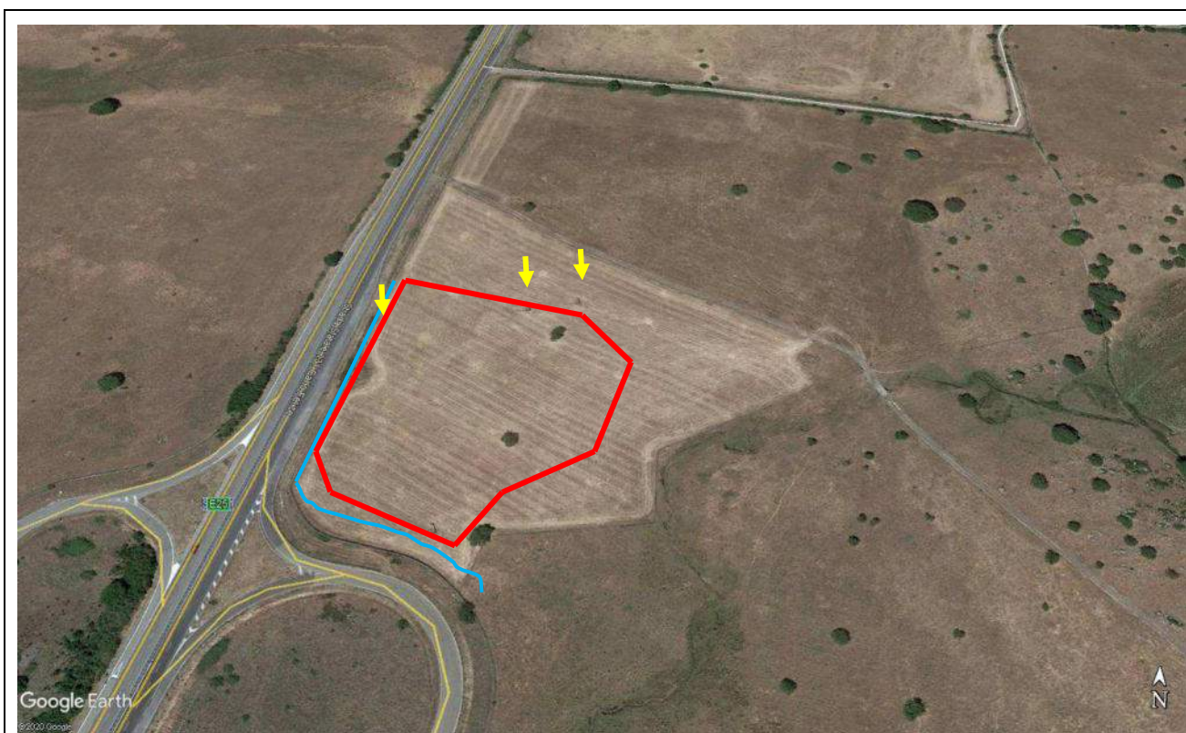
FOTO 9 - Panoramica dell'area del Campo Operativo CO.05 (perimetro in rosso). Le frecce in giallo indicano i sostegni metallici della linea elettrica in MT (esterni al perimetro del campo operativo). La linea ciano individua i muri in pietrame a secco che saranno mantenuti esterni al perimetro del cantiere.
