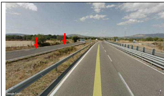
Foto 55c - Piazzola Km 136+050: panoramica - le frecce indicano il tracciato della SS 129
