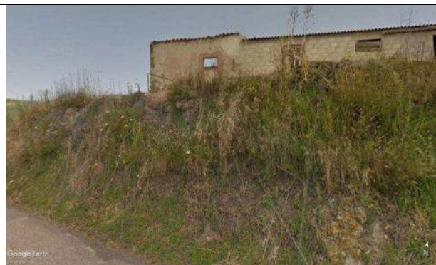
Foto 21a - Scarpata lato nord SS 121 con fabbricato al ciglio
