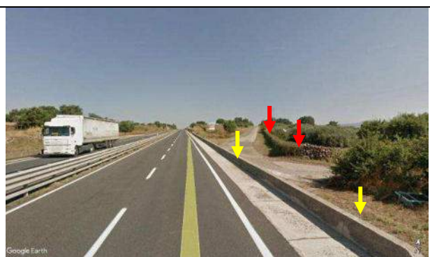
Foto 36d - CN: panoramica zona di innesco sez. 92; le frecce rosse indicano i muretti in pietrame; le frecce gialle indicano la cunetta in cls.
