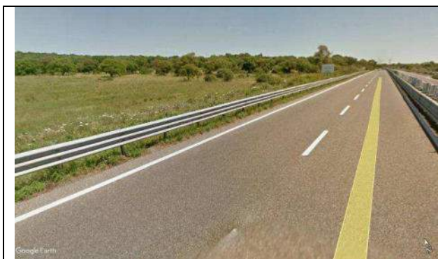
Foto 55a - Piazzola Km 121+450: panoramica
