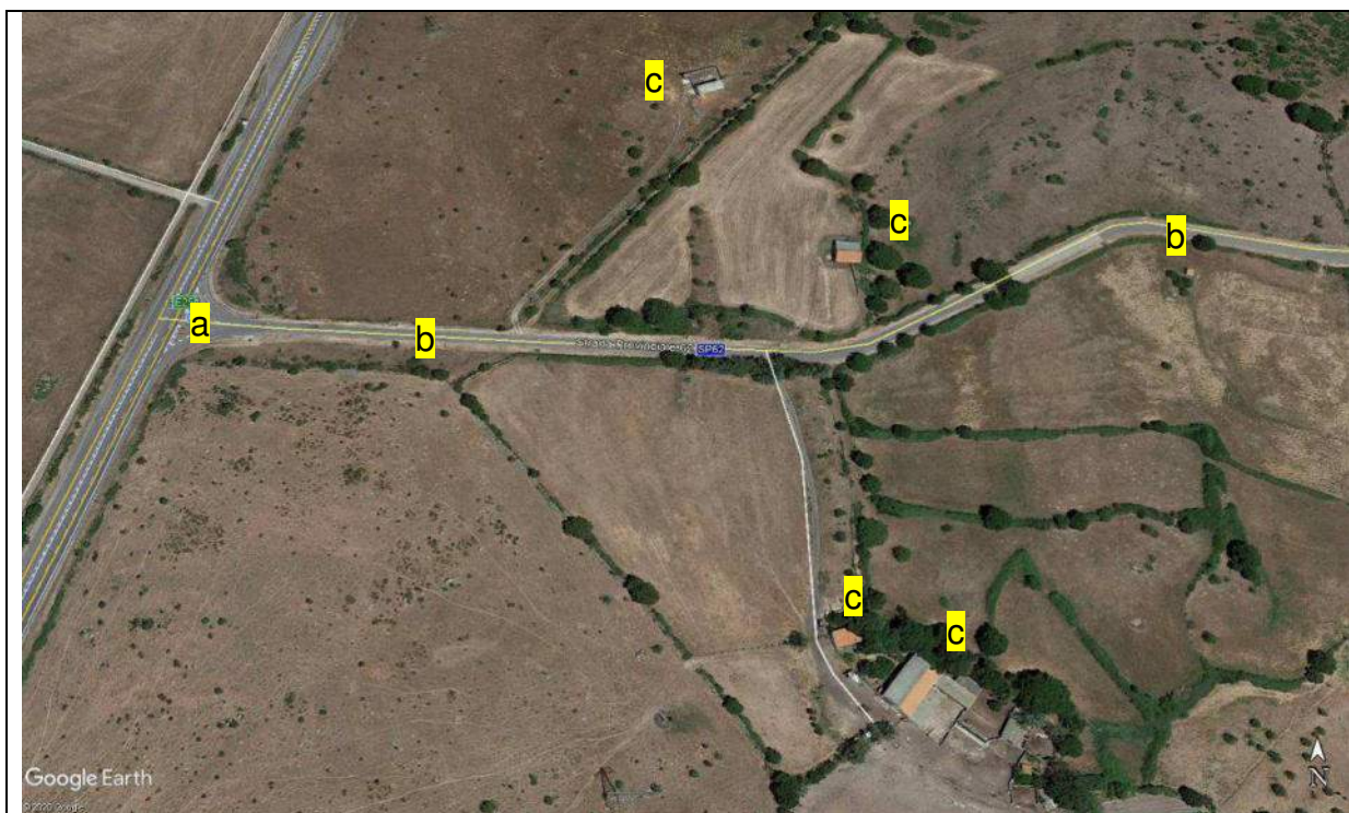
Foto 19 - Panoramica dello svincolo Mulargia dove si evidenziano i seguenti elementi: a= area di svincolo; b= asse della SP62; c= fabbricati
