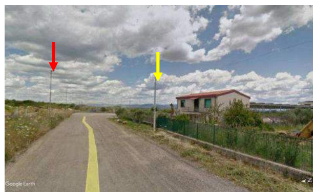
Foto 15 - Le frecce in giallo indicano la tipologia dei sostegni delle linee elettriche; le frecce in rosso indicano la tipologia dei pali di illuminazione stradale
