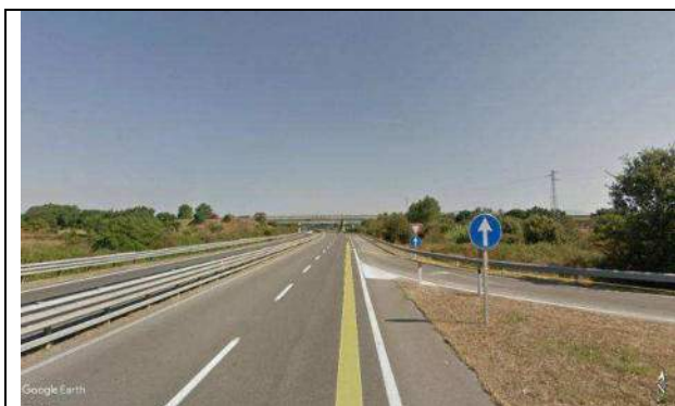
Foto 26a - Panoramica area corsia di accelerazione carreggiata nord.
