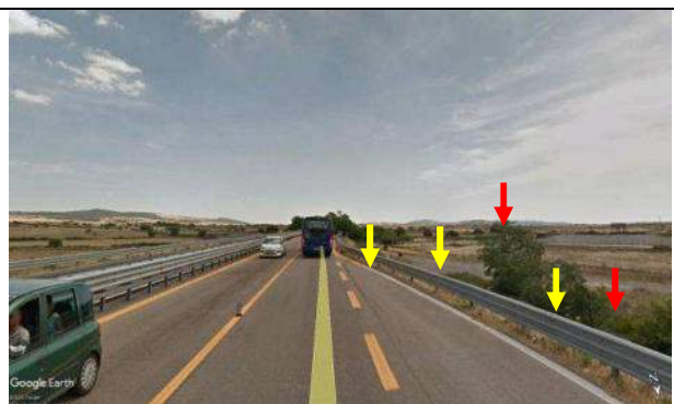
Foto 29b - Panoramica area di intervento carreggiata sud dove si evidenzia la barriera di sicurezza (frecce gialle) e la vegetazione presente sulla scarpata (frecce rosse)
