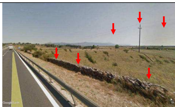
Foto 36b - CN: Le frecce indicano i muretti di recinzione, la linea elettrica di Mt con i relativi tralicci.
