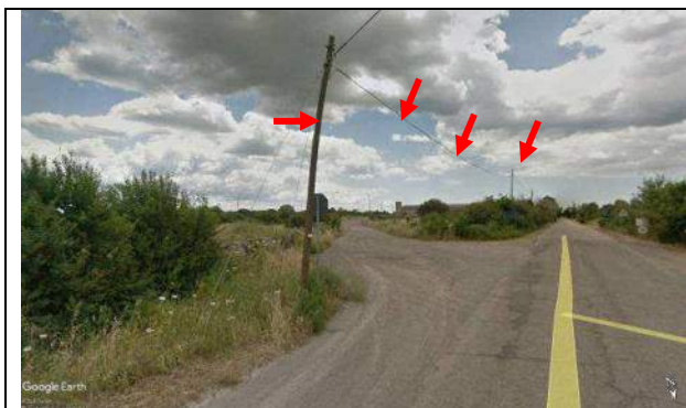
Foto 34a - Panoramica area incrocio con via Nazionale; le frecce indicano l'interferenza con in sostegni e la linea telefonica.
