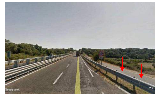
Foto 24a - Panoramica area di intervento carreggiata nord; le frecce rosse indicano il livello della comunale rispetto alla SS131
