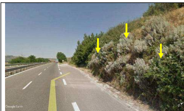
Foto 28a - Panoramica corsia di decelerazione accesso area parcheggio S. Barbara; le frecce indicano il pendio a forte pendenza
