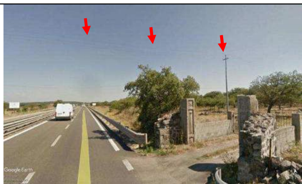
Foto 48f - S17 CN: attraversamento linea Mt sez. 107 (freccette rosse)
