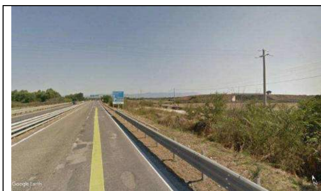
Foto 54g - SS131: attraversamento linea TERNA
