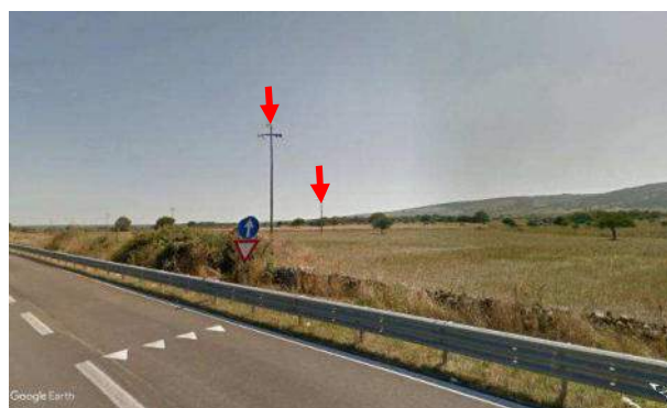
Foto 11 - Le frecce in rosso indicano i sostegni della linea elettrica di MT.
