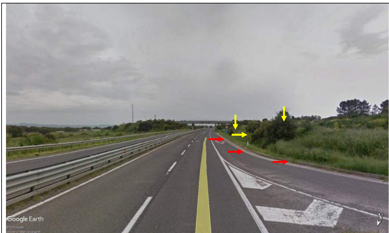
Foto 26c - Panoramica area corsia di accelerazione carreggiata sud immissione da Norbello dove si evidenziano: la cunetta in cls (frecche rosse); la scarpata con presenza di essenze arbustive e vegetazione xerofila (frecche gialle)
