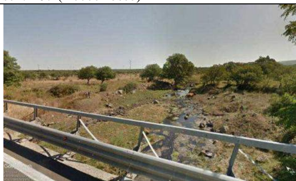
Foto 48h - S17 CN: attraversamento torrente sez. 15-18)
