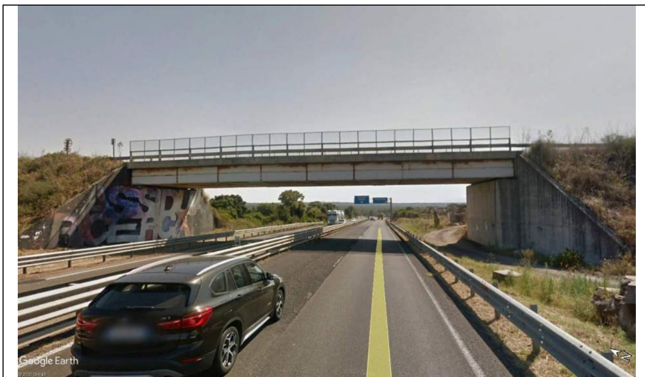
Foto 56 - Panoramica cavalcavia Paulilatino Km 120+316 da mantenere
