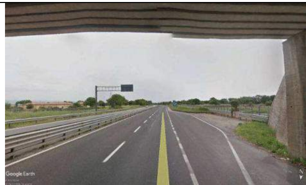
Foto 27b - Dettaglio della spalla del cavalcavia e della piazzola di sosta.
