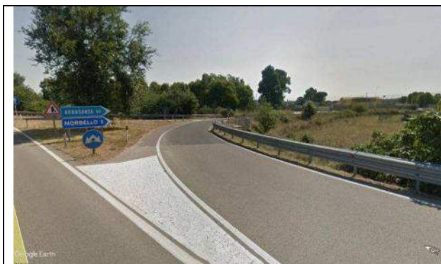
Foto 25a - Panoramica area rampa di uscita per Abbasanta-Norbello.
