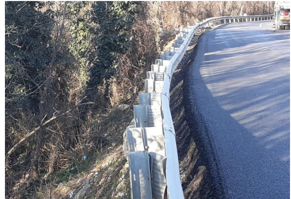
Figura 26 – Indicatore di deformazione: barriera stradale ribassata o con sommità a bassa quota rispetto al piano viabile, per effetto di frequenti e ripetute ricariche e cedimenti. A sx: tratto tra Dolgo e Quadrelli, a Sud del Rio Mulini; a dx: frana attiva presso Fabbiano
