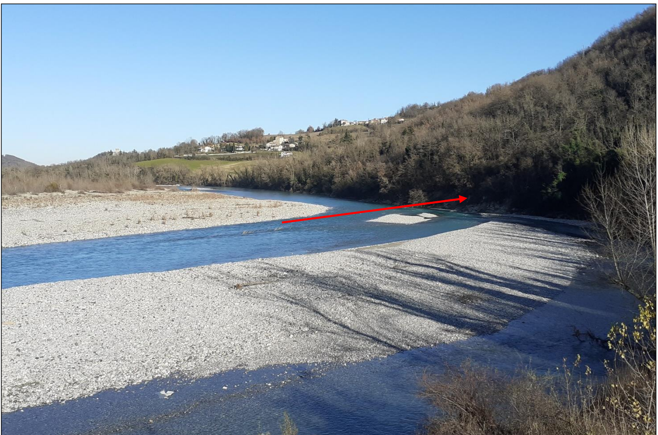
Figura 12 – Versante soggetto a sottoscalzamento in sponda destra, a valle del ponte di Travo
