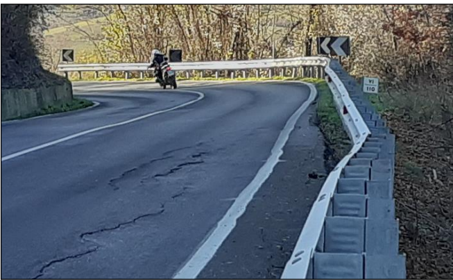
Figura 26 – Indicatore di deformazione: barriera stradale ribassata o con sommità a bassa quota rispetto al piano viabile, per effetto di frequenti e ripetute ricariche e cedimenti. A sx: tratto tra Dolgo e Quadrelli, a Sud del Rio Mulini; a dx: frana attiva presso Fabbiano
