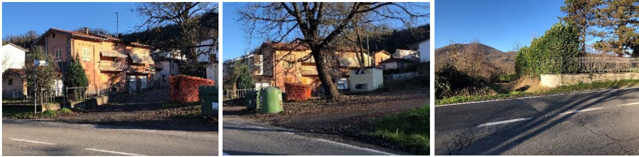
Figura 26 - Vista degli innesti 21 (sx), 22 (centro) e 23(dx) dalla SS.45
