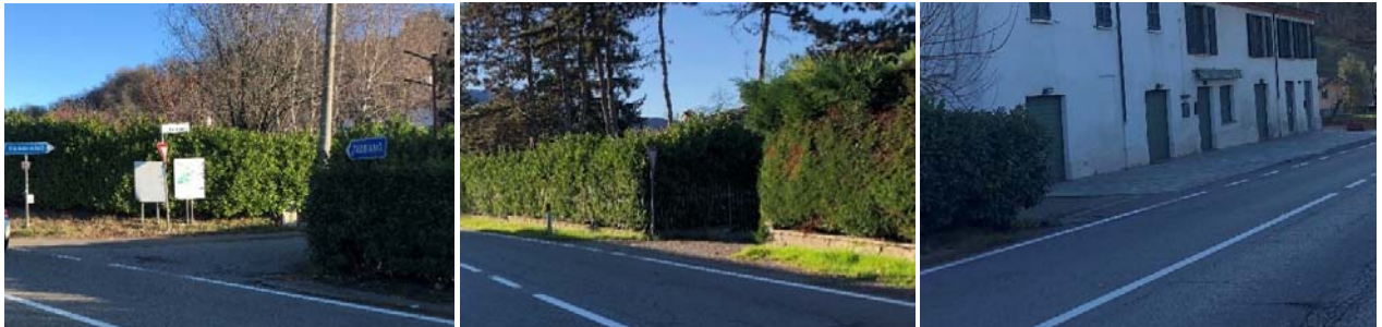
Figura 24 - Vista degli innesti 16 (dx), 17 (centro), 18 (sx) dalla SS.45
