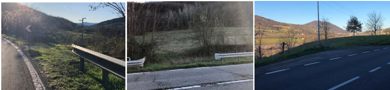
Figura 57- Vista degli innesti 87 (sx), 91 (centro) e 95 (sx)
