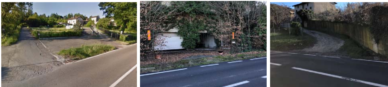
Figura 35 - Vista degli innesti 36 e 37 (sx), 38 (centro), 39 (sx)
