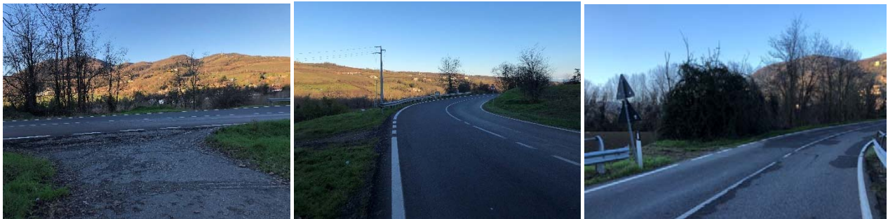
Figura 20 - Vista dell'innesto 9 (sx). Vista dell'innesto 10 (centro) dalla SS.45. Vista dell'innesto già esistente sulla SP.40(dx)
