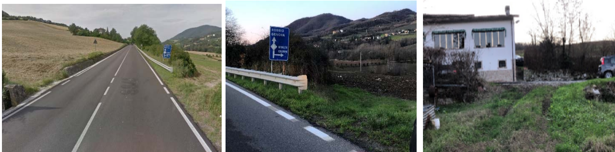
Figura 15 - Vista dell'innesto 1 dalla SS.45 (sx). Particolare dell'innesto 1 (centro). Vista dell'innesto già esistente sulla SP40 dal fondo agricolo (dx).
