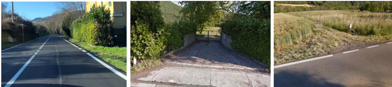
Figura 33 - Vista degli innesti 38bis (sx), 40 (centro) e 42 (dx)
