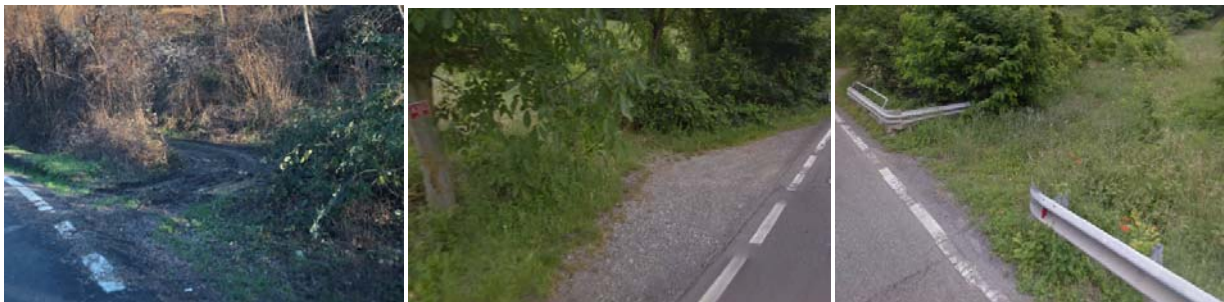
Figura 58 - Vista degli innesti 88 (sx), 90 (centro) e 92 (sx)
