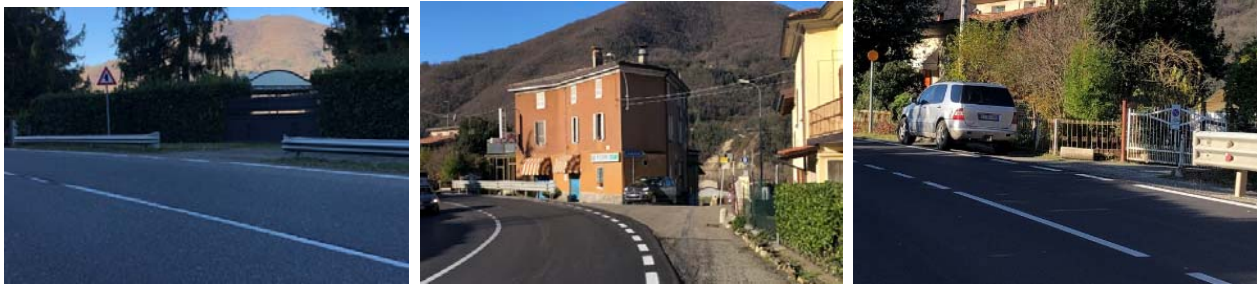
Figura 30 - Vista dell'innesto 31 (sx), 33 (centro) e 34 (dx)
