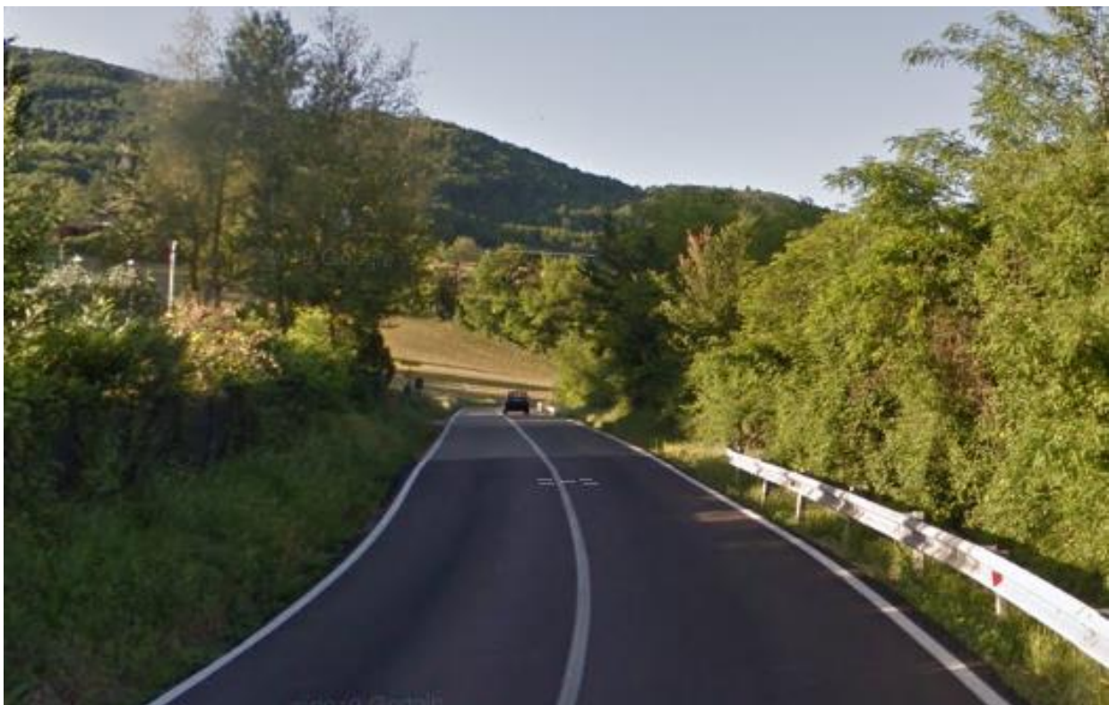
Tratto 4 - Foto 20– S.S.45 all'altezza di Località Colombarola
