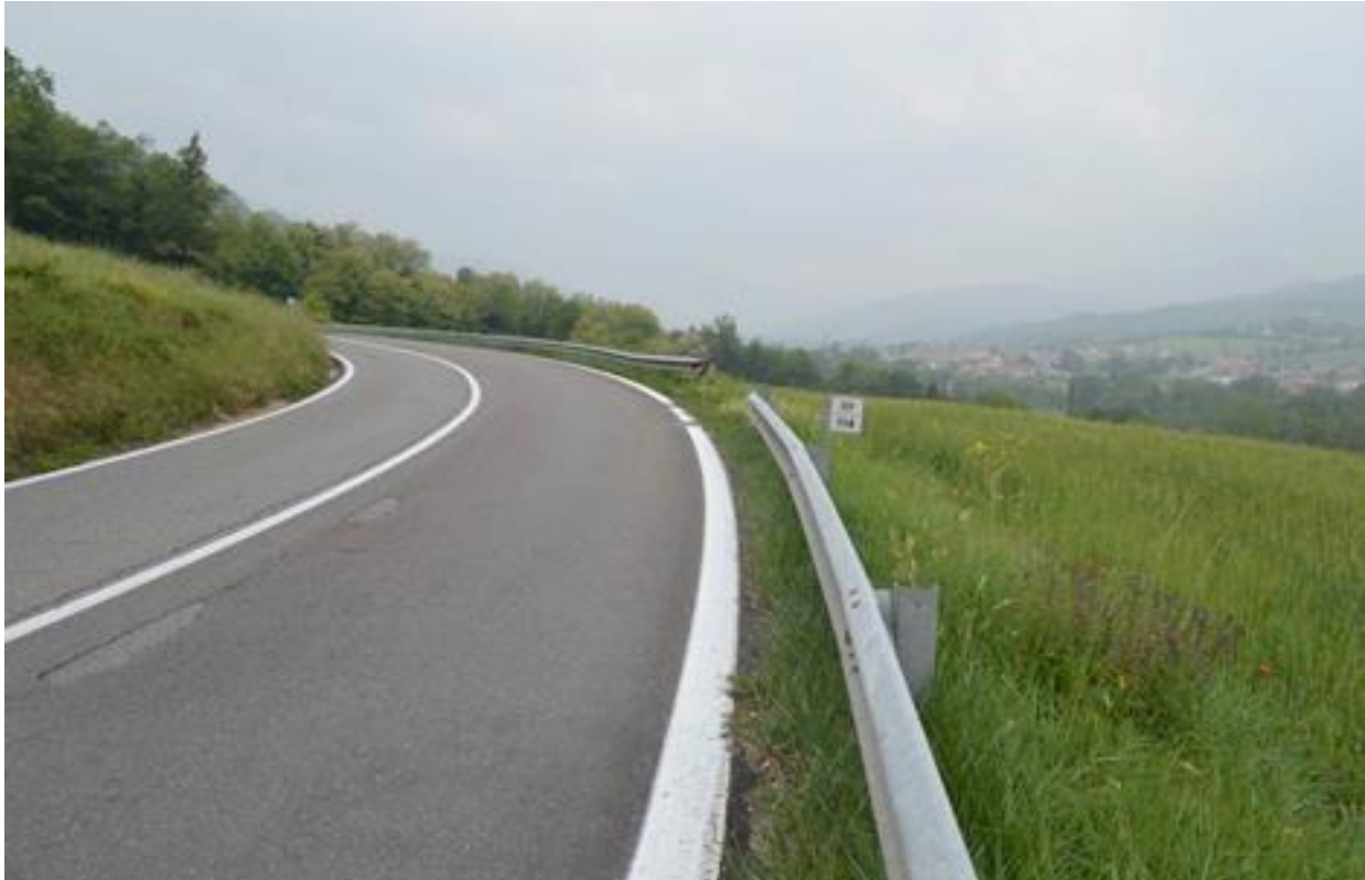
Tratto 4 - Foto 21– S.S.45 al Km 114 in località Coni di sotto
