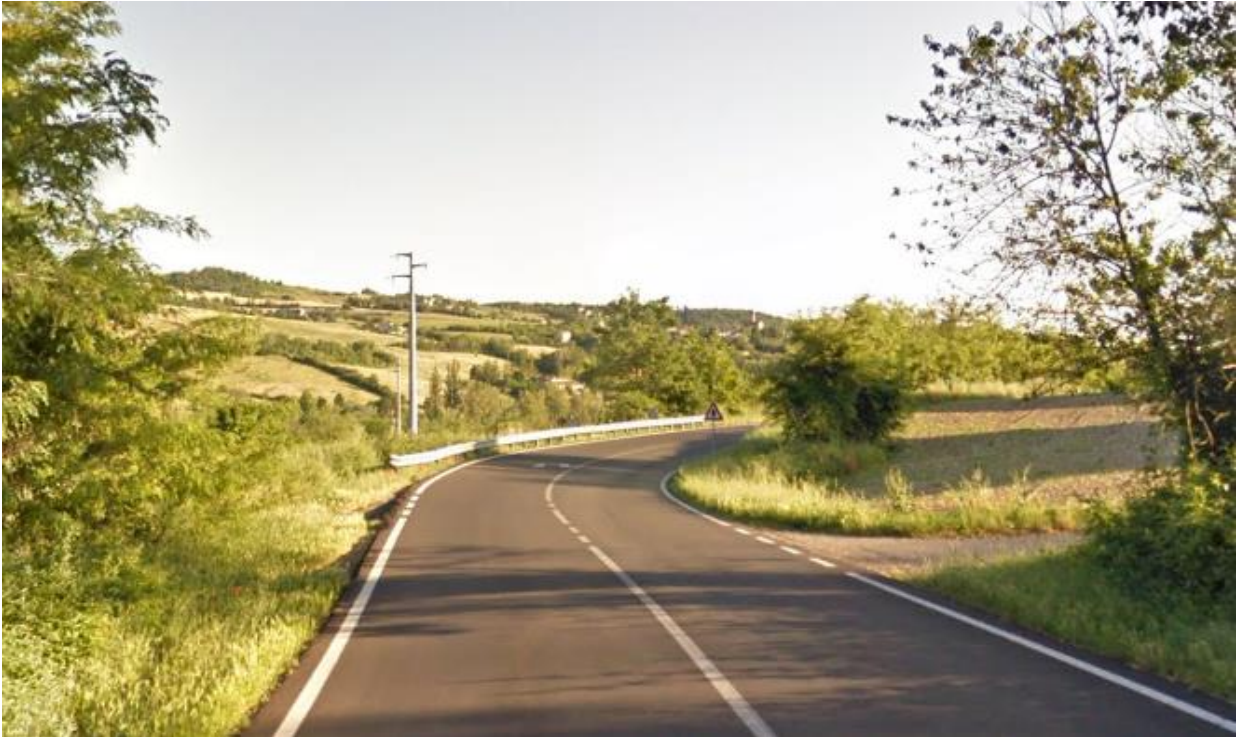
Tratto 1 - Foto 4– Progressiva all’altezza della Cascina Savigliano
