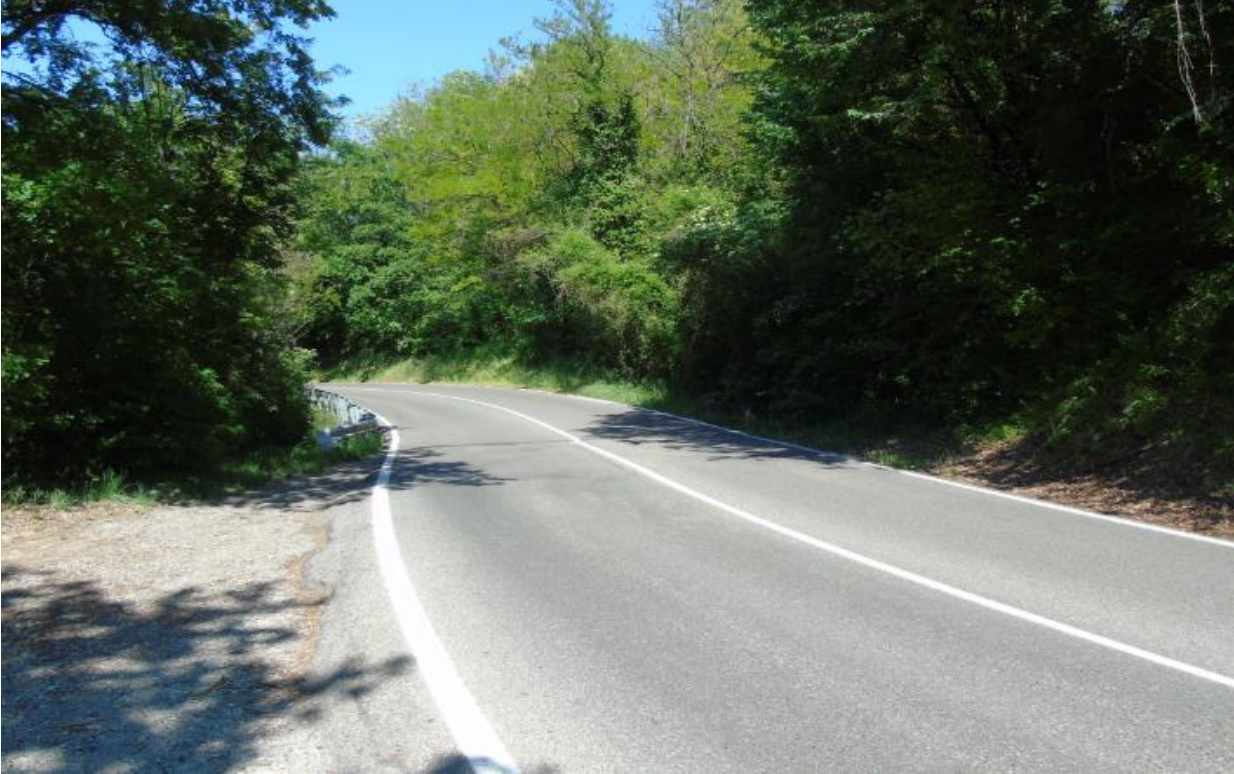
Tratto 6 - Foto 30– S.S.45 all'altezza del Km 111
