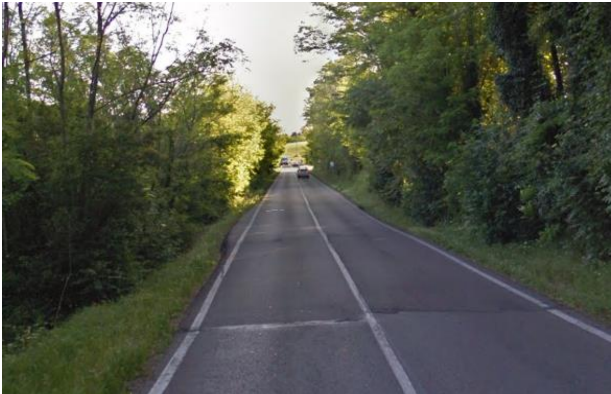
Tratto 4 - Foto 19– Ambito di realizzazione della rotatoria n. 3
