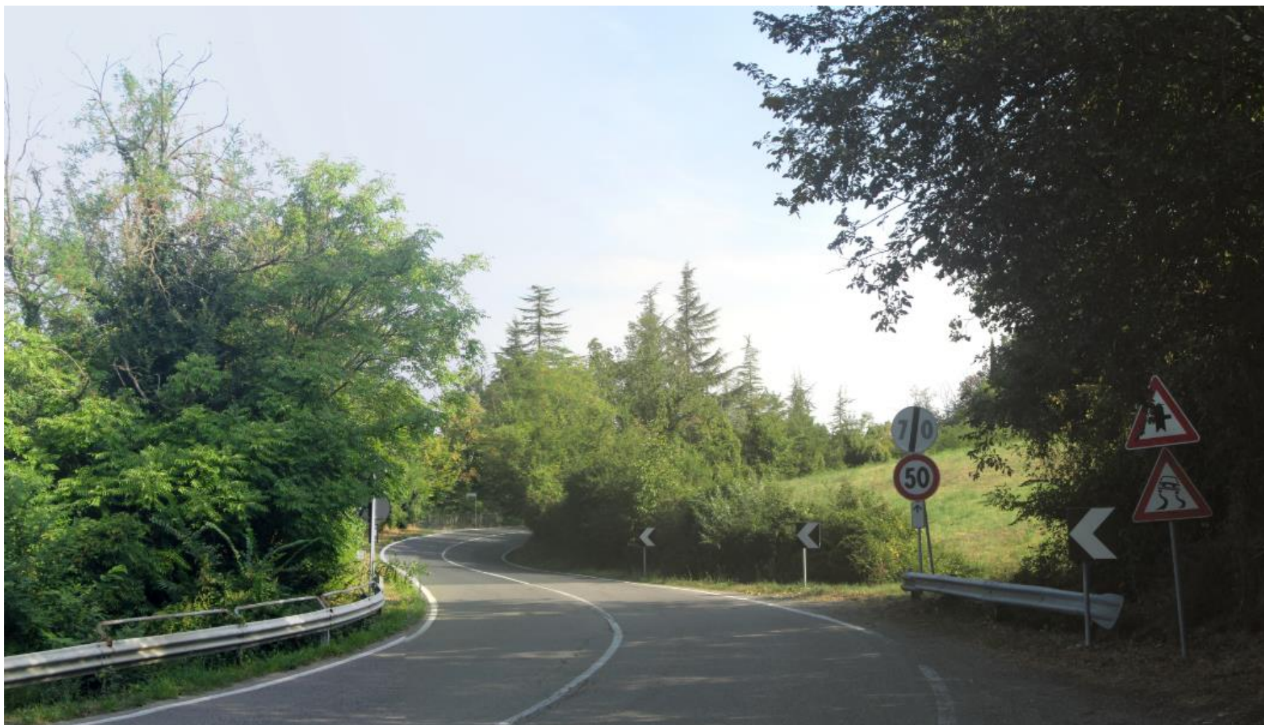
Tratto 1 - Foto 8 – S.S. 45, ambito di realizzazione della rotonda n.1
