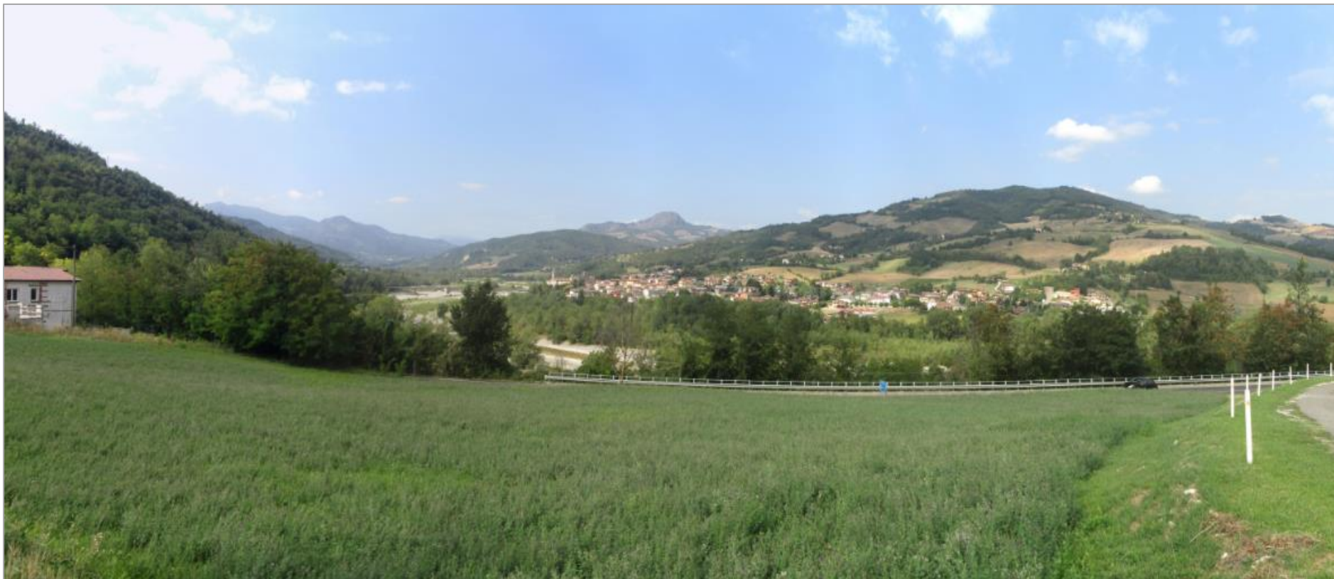
Tratto 4 - Foto 23– Vista della S.S. 45 all'altezza della costruenda rotonda n. 4 dalla strada comunale per Coni
