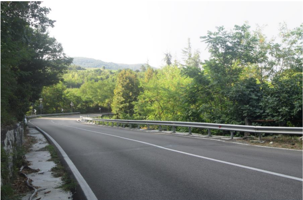
Tratto 1 - Foto 7– S.S. 45, tratto all'altezza del ponte sul Rio dell'Acqua Rossa
