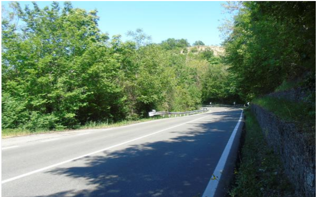
Tratto 6 - Foto 33– S.S. 45 – ambito di realizzazione della rotonda n. 6
