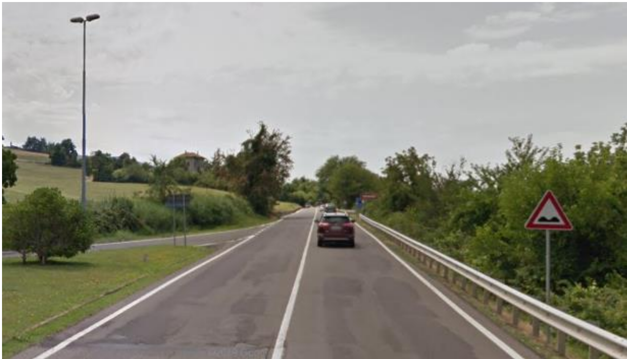
Tratto 1 - Foto 1 – Inizio intervento di ammodernamento della SS.45 corrispondente al chilometro 121,500 (progressiva di progetto 00,00) all'innesto di Via Genova del Comune di Rivergaro
