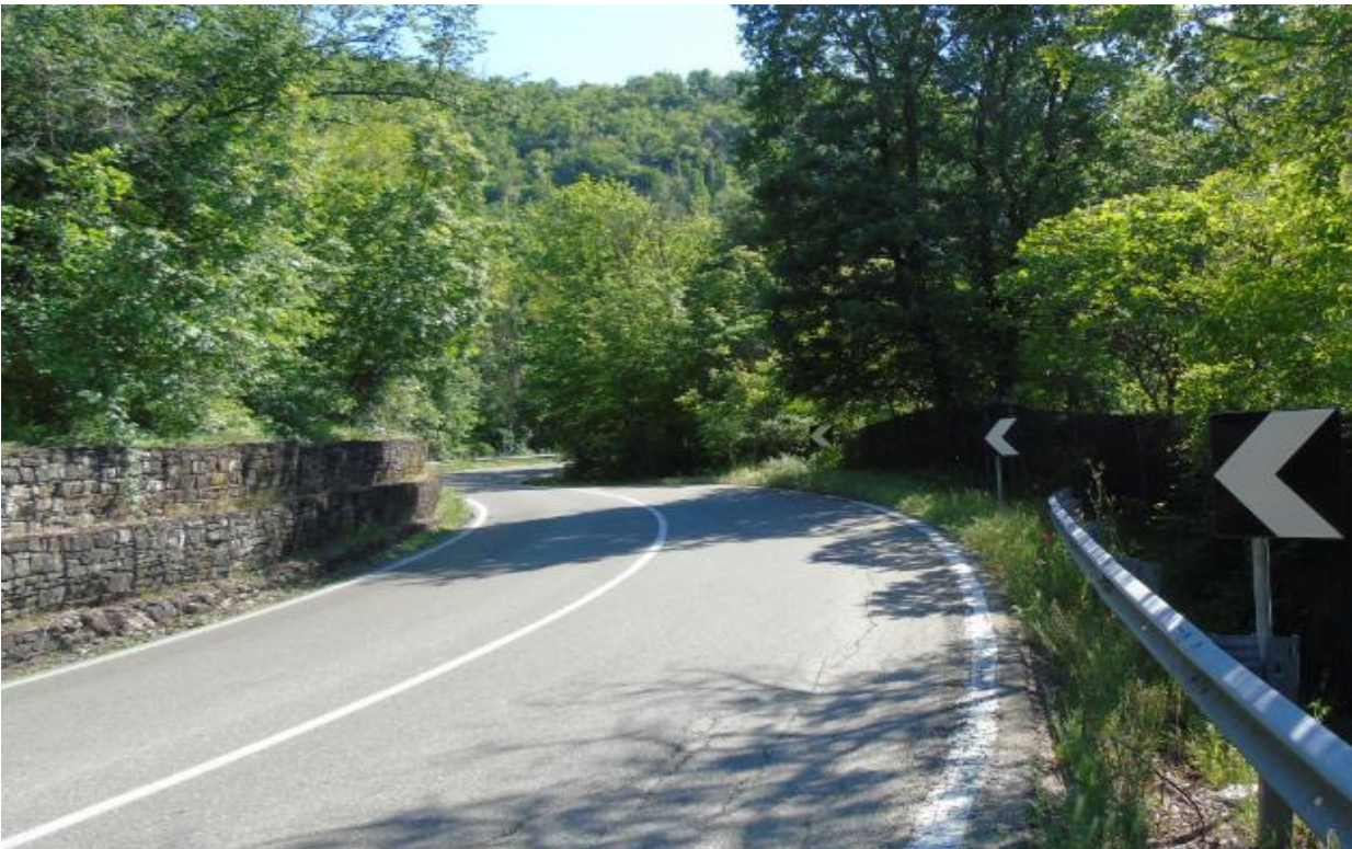
Tratto 6 - Foto 31– S.S. 45 in prossimità dell'attraversamento del Rio Molini
