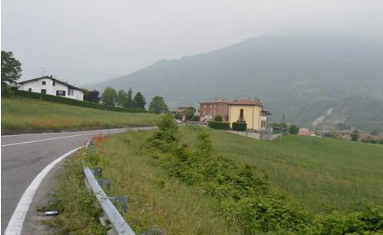
Tratto 2 - Foto 12– S.S. 45 in località Cisiano di sotto
