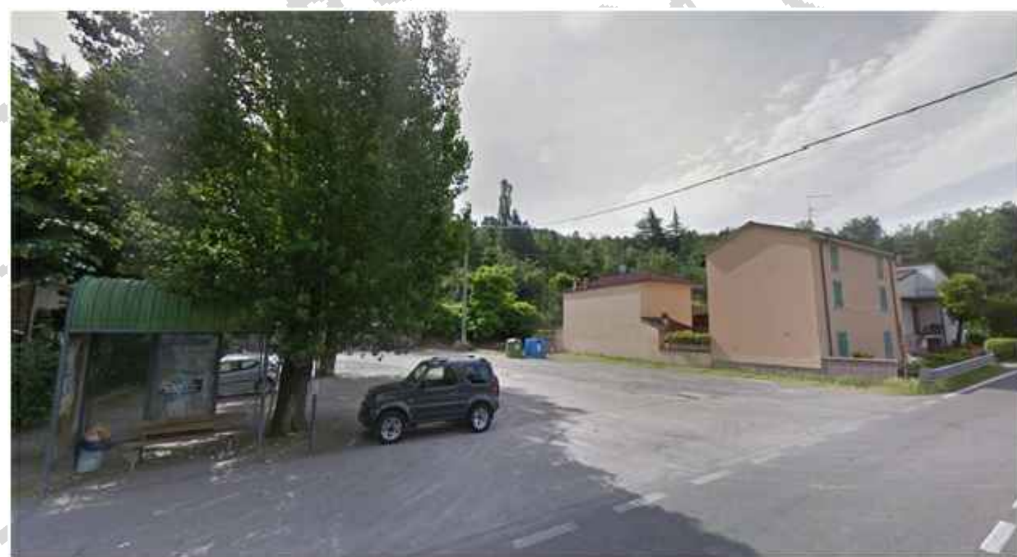
Punto di vista B cantiere di base B2
