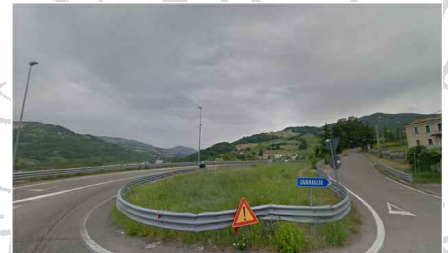
Punto di vista B cantiere di base B3
