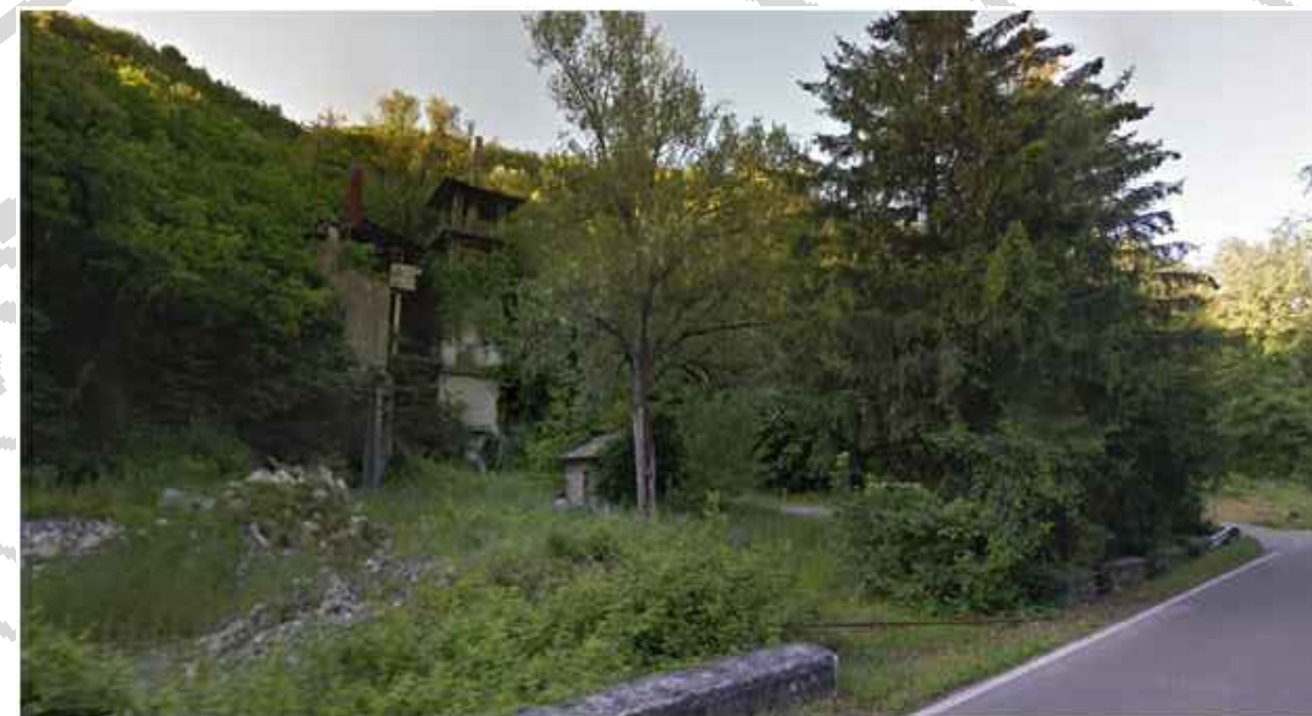
Punto di vista B cantiere di servizio CS2
