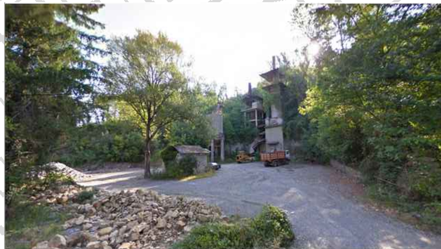
Punto di vista A cantiere di servizio CS2
