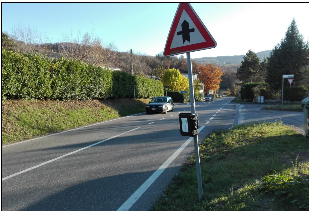
Img. 4.3 -Strada Statale S.S. n. 45, sezione T2
