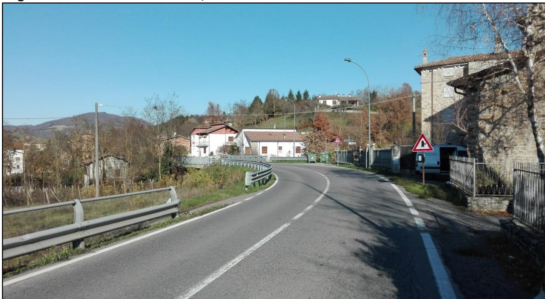
Img. 4.2 -Strada Statale S.S. n. 45, sezione T1
