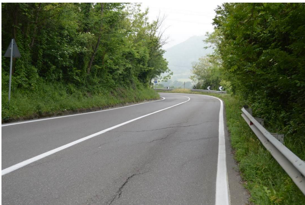
Fig. 8.4: SS 45, km 117, tratta di intervento in località Cisiano di sotto.
