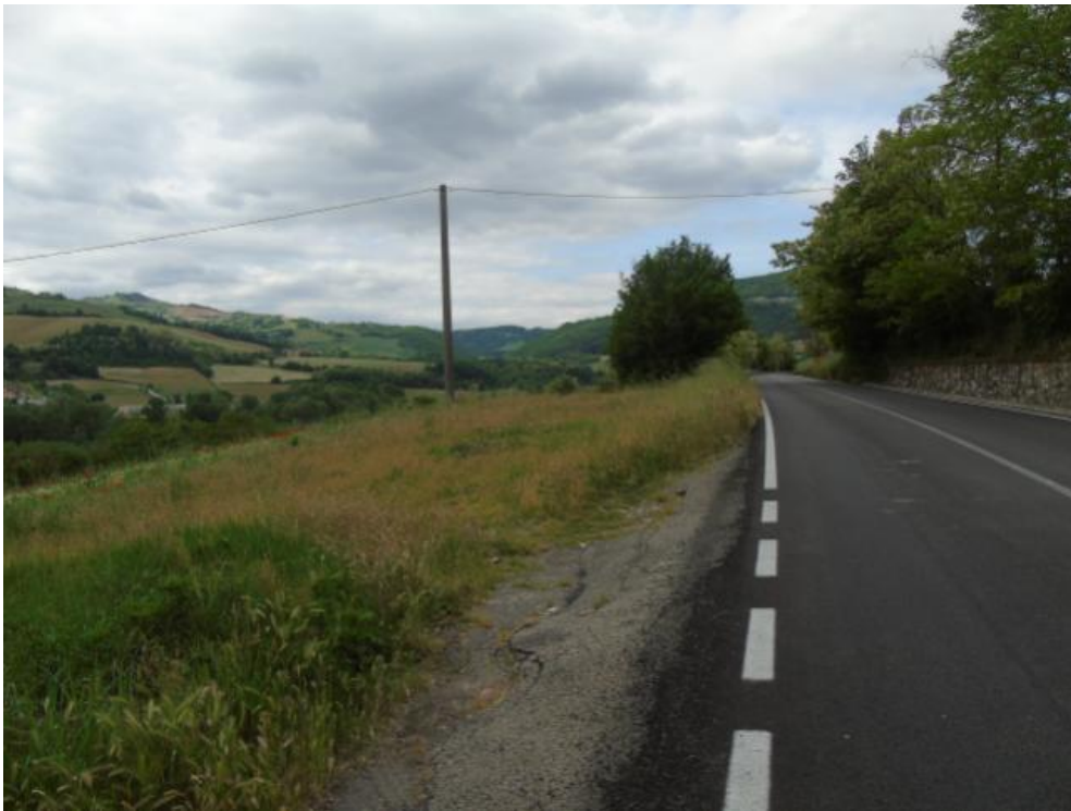
Fig.8.18 S.S.45 allargamento carreggiata in località Coni Sotto, comune di Travo
