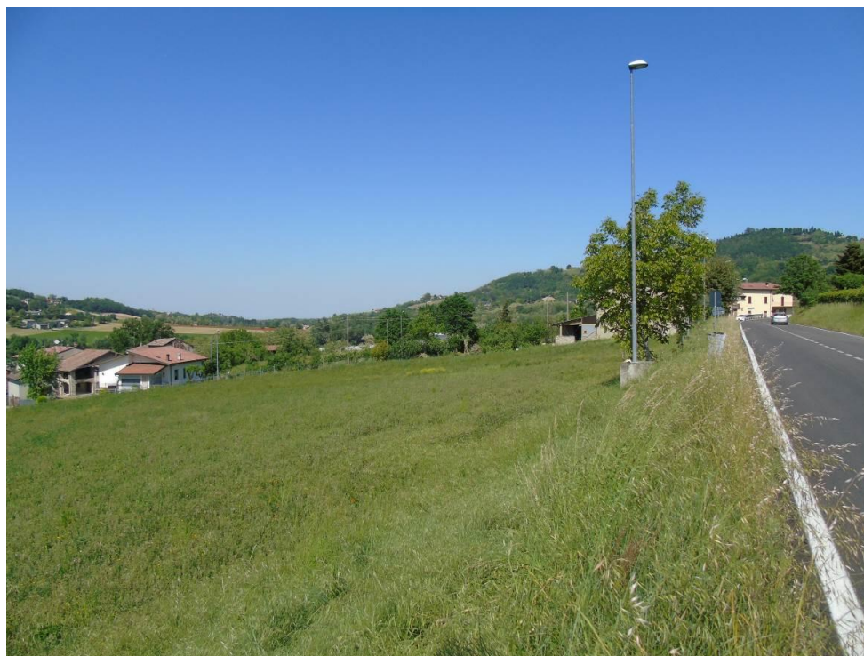
Fig.8.16 S.S.45 Rotatoria 2 località Cisiano-Monte Travaso comune di Rivergaro. Tratto interessato da allargamento della Carreggiata
