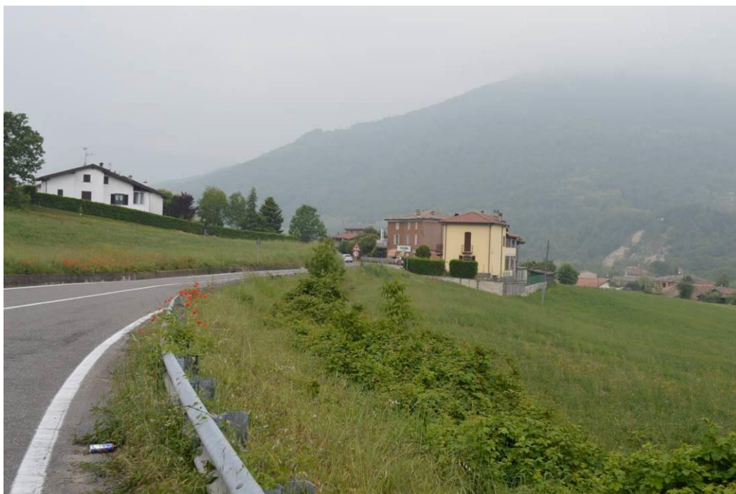
Fig. 8.5: SS 45, segmento tratta di intervento in località Cisiano di sotto.
