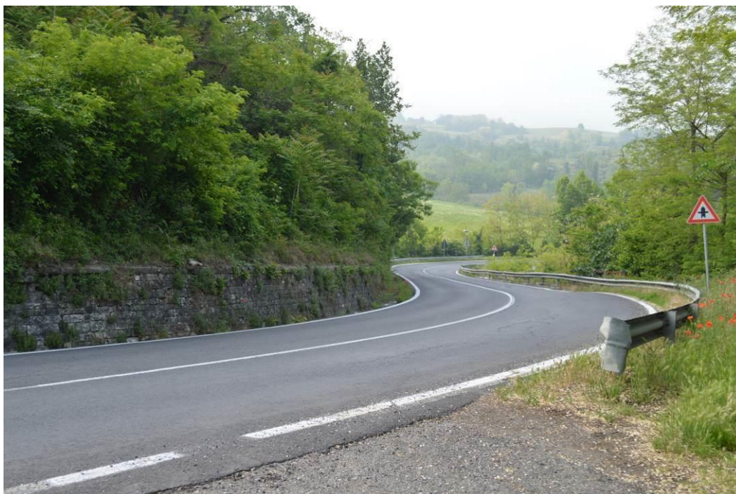
Fig. 8.3 SS 45, settore della di intervento, in località Fabiano
