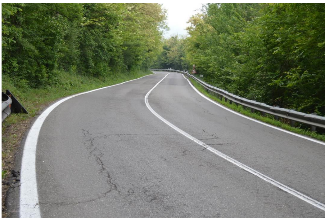
Fig. 8.8 SS 45, tratta di intervento, località Piana (tra Casino Agnelli e Quadrelli).
