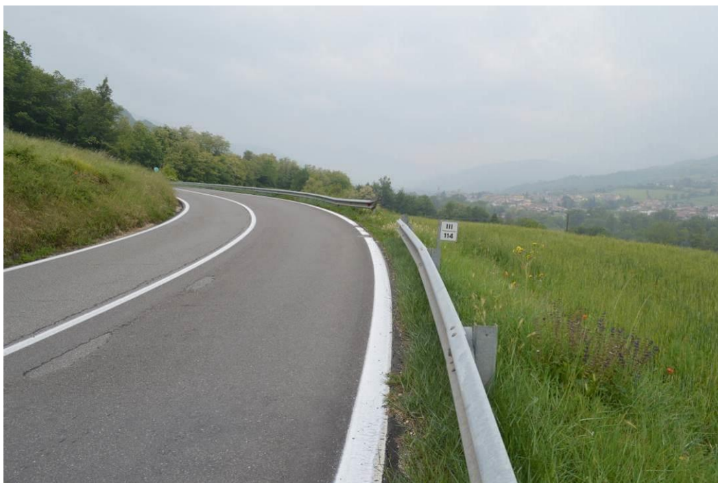
Fig. 8.7: SS 45, km 114, tratta di intervento, in località Coni di sotto.
