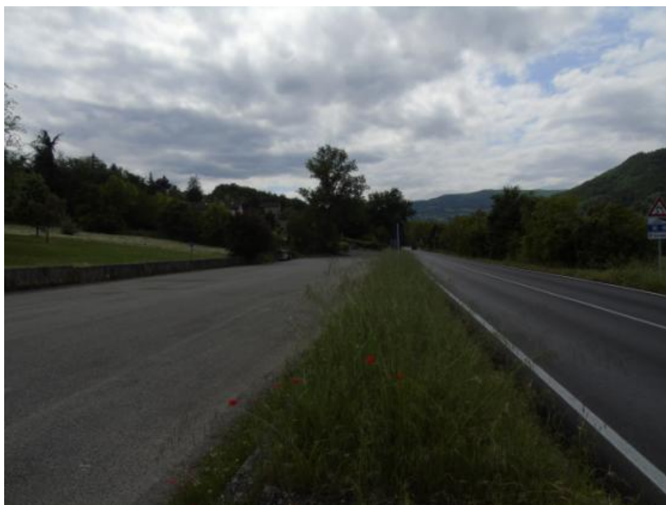
Fig.8.15 S.S.45 Rotatoria 2 località Cisiano-Monte Travaso comune di Rivergaro
