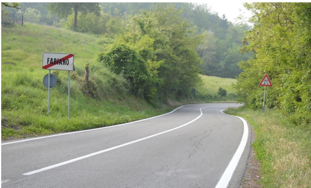
Fig. 8.2 SS 45, tratta di intervento in località Fabiano
