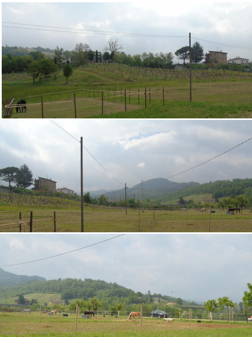
Figg. 8.10-8.11-8.12 SS 45, ultima tratta di intervento, in località Cernusca, collegamento con l'esistente rotonda mediante viadotto.
