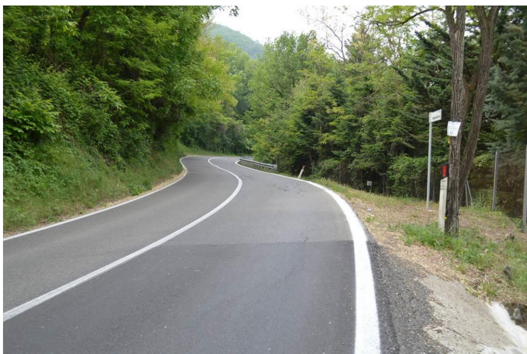
Fig. 8.10 SS 45, settore della tratta di intervento, in località Cà Teresa
