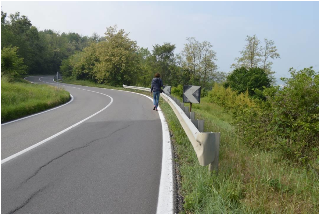
Fig 8.1 SS. 45, tratta di intervento nei pressi della località La Valle-Savignano
