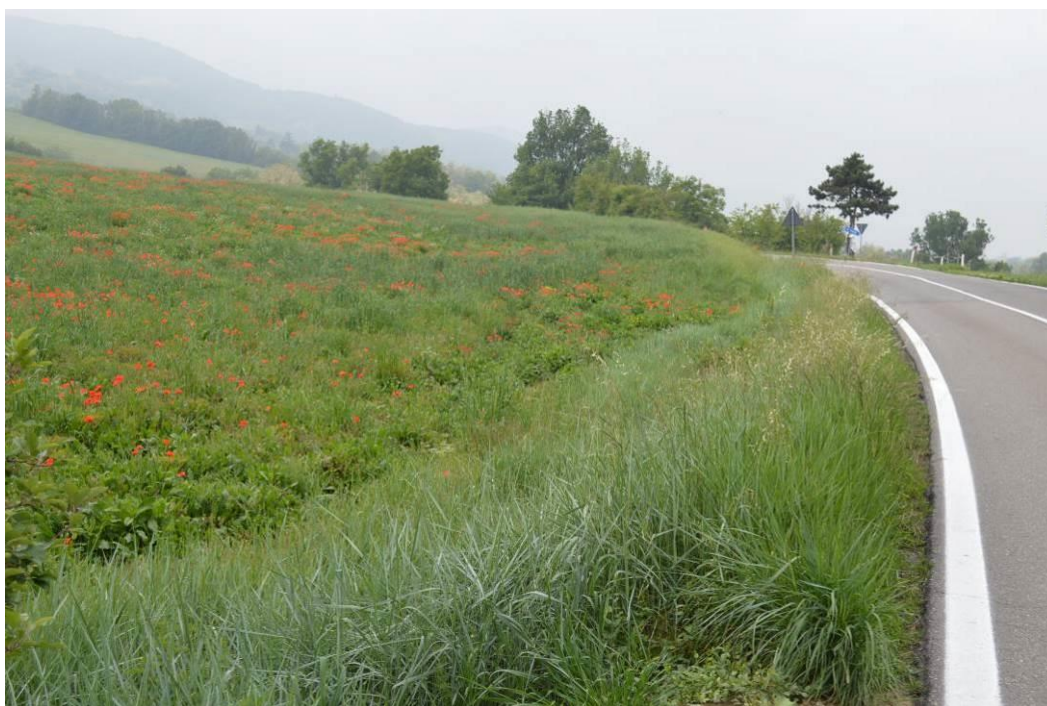
Fig. 8.6: SS 45, tratta di intervento, in località Le Piane, attraversamento sull'area a prato.
