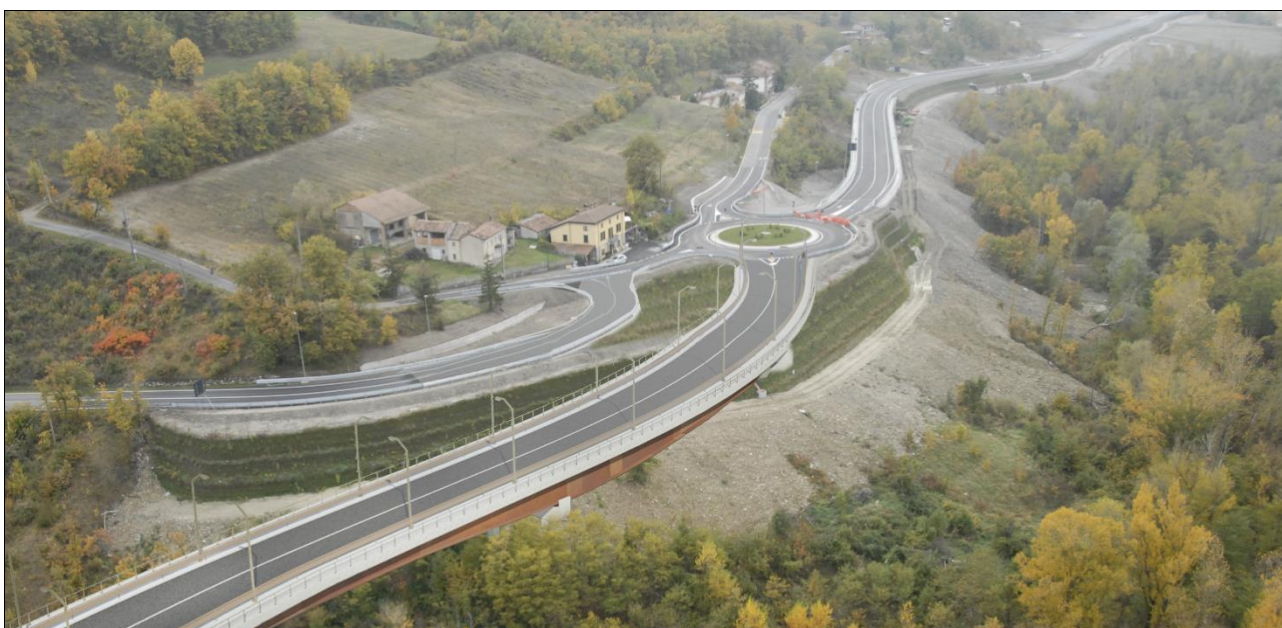
Figura 9.3/6: Ponte sul rio Cernusca – Tratto terminale di raccordo con la rotatoria 8
