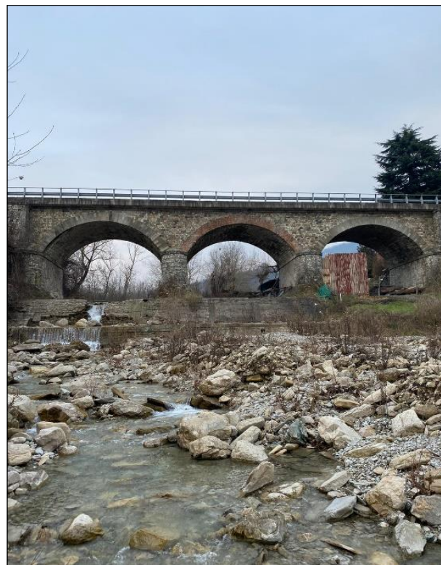
Tratto 8 - Foto 41 – Il ponte attuale sul Rio Cernusca, mantenuto al servizio della viabilità locale
