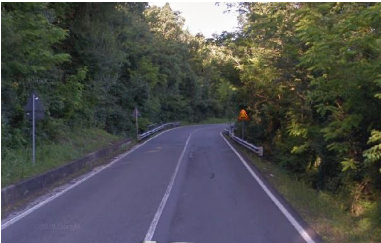
Tratto 5 - Foto 26– Tratto della S.S.45 all'altezza del ponte sul Rio Signano
