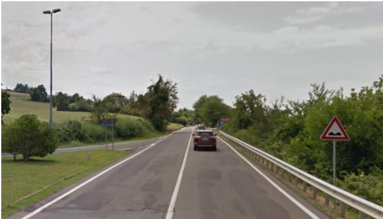
Tratto 1 - Foto 1 – Inizio intervento di ammodernamento della SS.45 corrispondente al chilometro 121,500 (progressiva di progetto 00,00) all'innesto di Via Genova del Comune di Rivergaro
