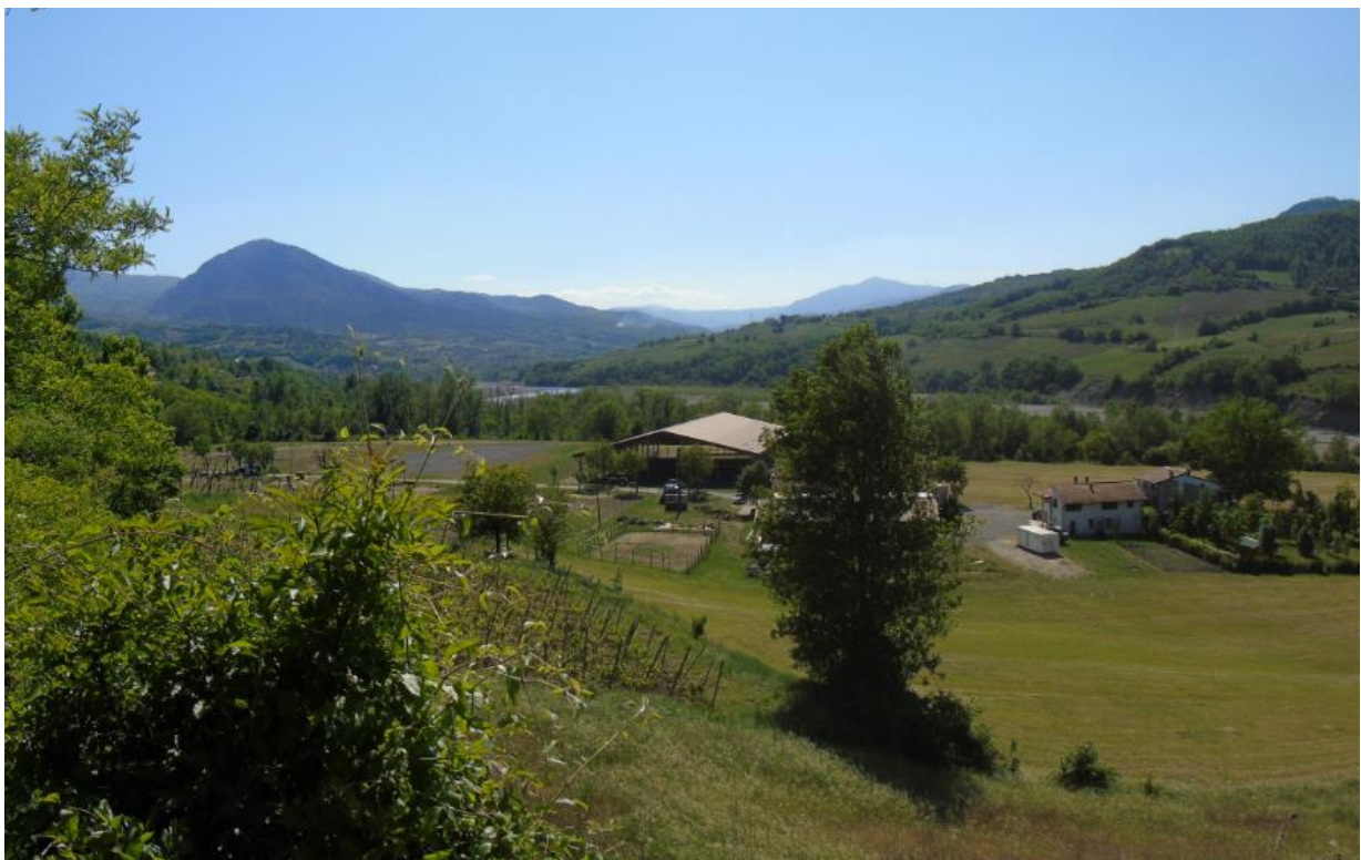
Tratto 8 - Foto 38 – Dal bordo della S.S. 45 – Punto di inizio del viadotto Cernusca – Vista direzione sud
