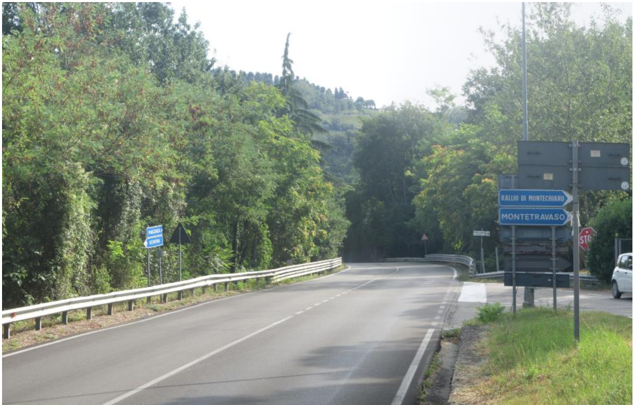
Tratto 2 - Foto 10– S.S. 45 all’altezza del ponte sul Rio Mortale
