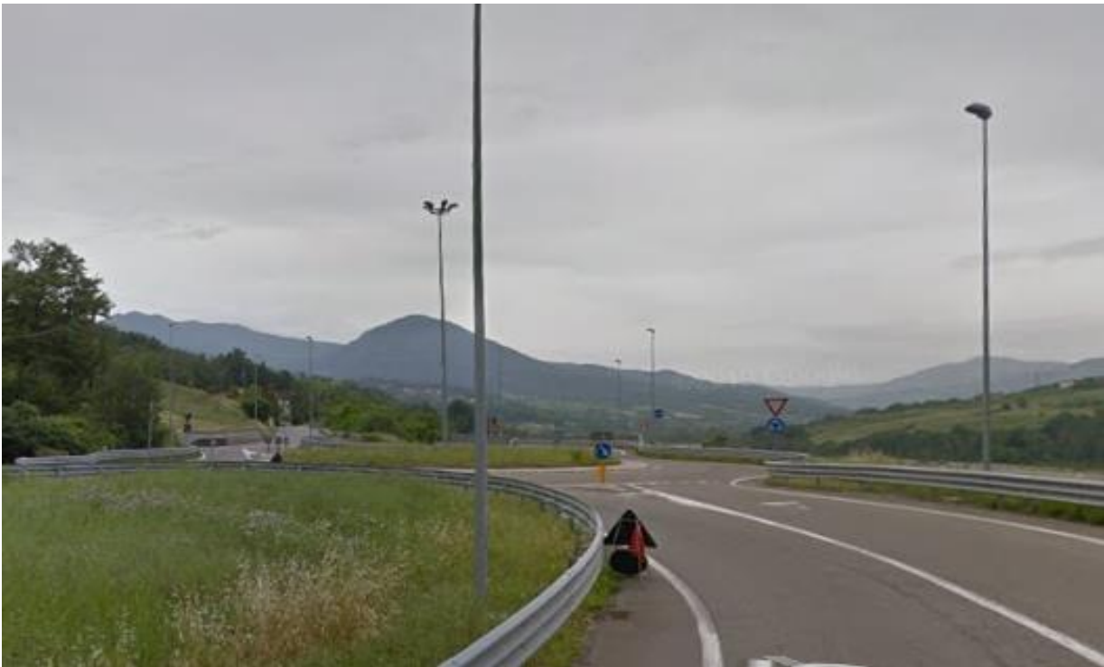
Tratto 8 - Foto42–Termine intervento - Rotatoria 8 – Raccordo all'attuale tracciato della S.S 45
