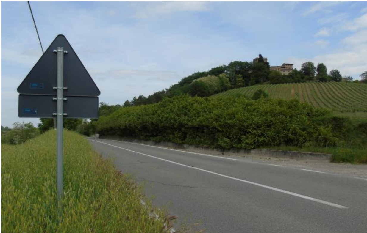
Tratto 3 - Foto 17–Tratto della S.S.45 all’altezza del castello di Montechiaro
