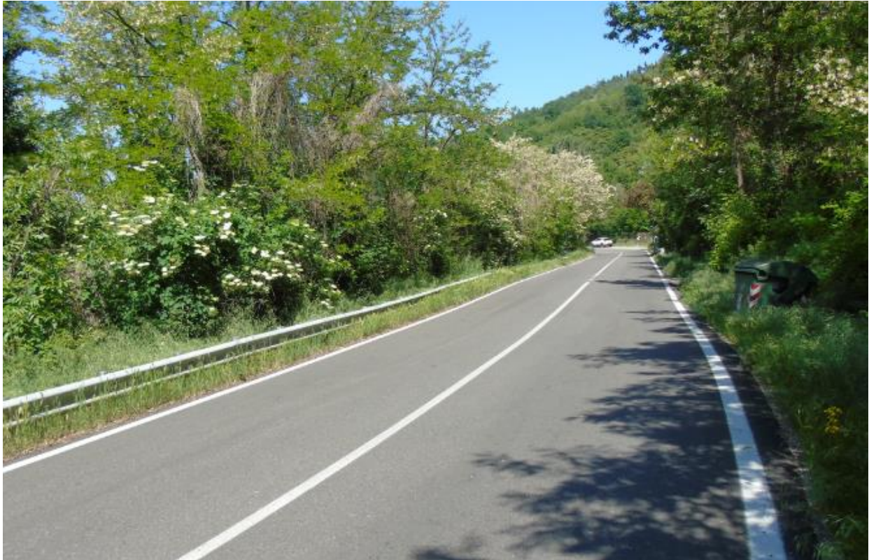
Tratto 2 - Foto 9– S.S. 45, tratto all’altezza della Frazione Mulinazzo
