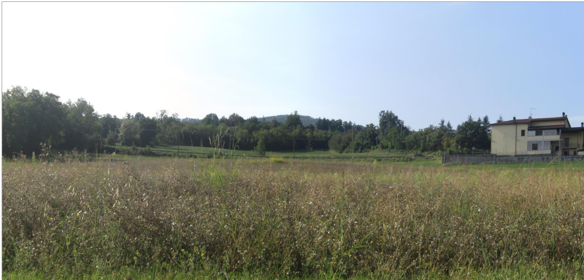
Tratto 2 - Foto 14 – Vista della S.S. 45 dalla strada interpodereale in uscita dall'abitato di Cisiano di sotto
