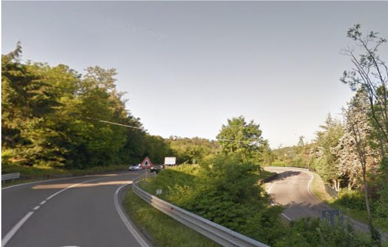
Tratto 5 - Foto 25– Località Canova Ponte, Ambito di realizzazione della rotatoria n. 5
