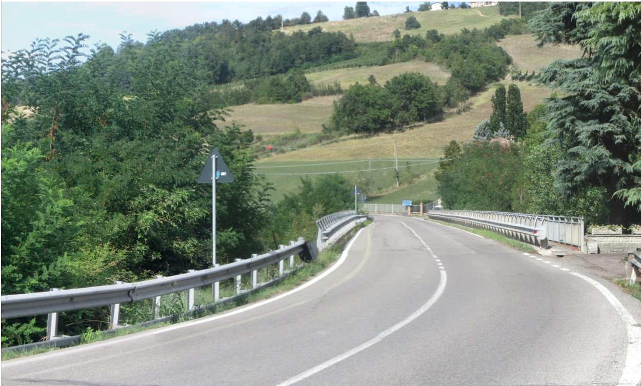
Tratto 8 - Foto 40– S.S. 45 – attraversamento del Rio Cernusca
