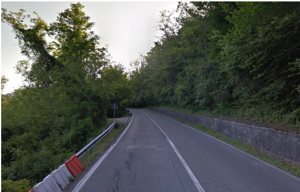
Figura 3.4-12: formazioni boscate di ripa di prevista eliminazione per l'adeguamento stradale in oggetto
