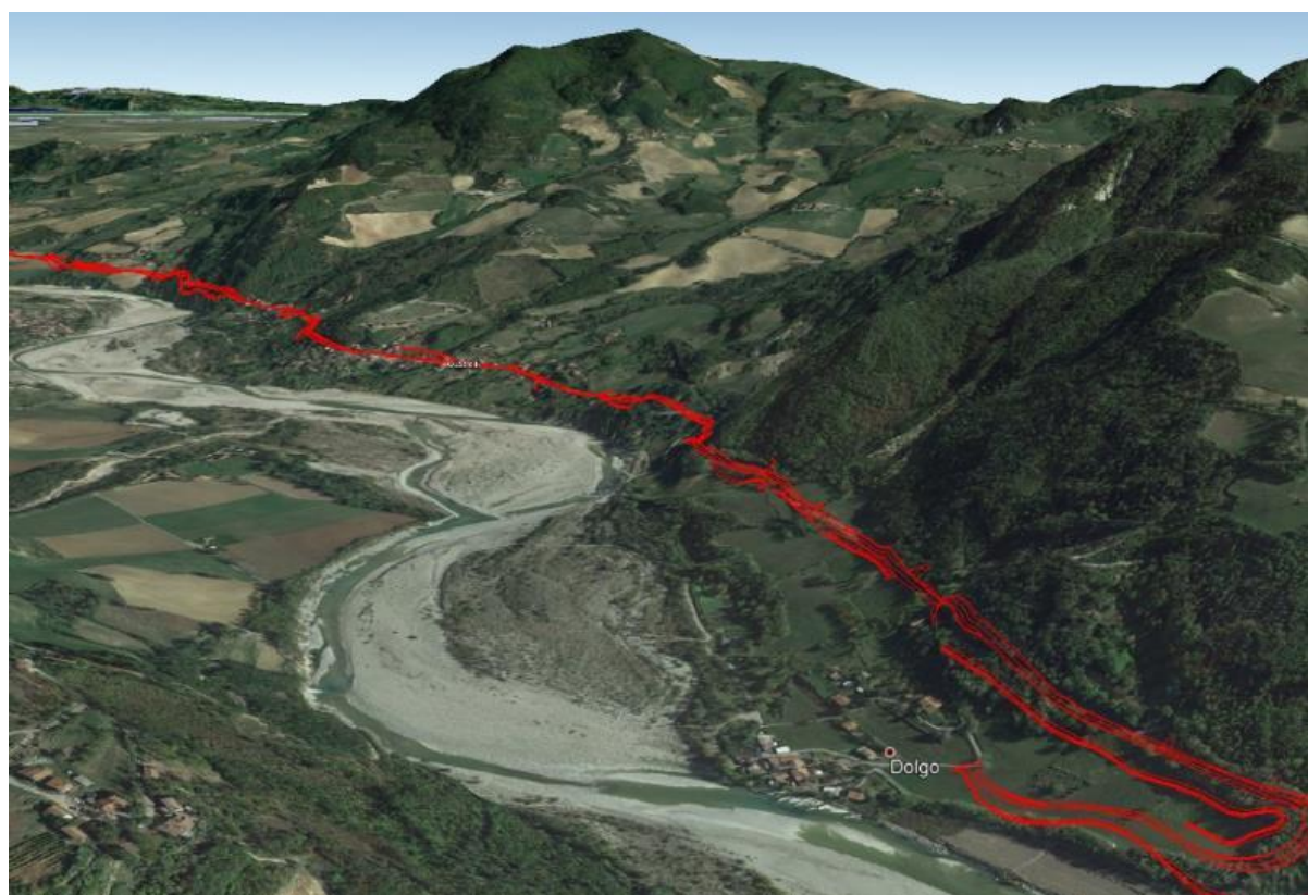
Figura 3.1-3: morfologia della Val Trebbia dall'abitato di Dolgo all'abitato di Quarelli
