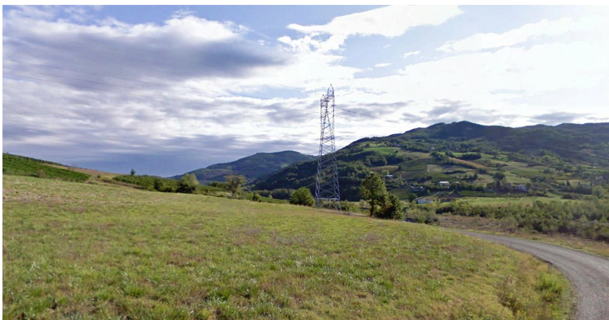
Figura 3.4-23: rete elettrica quale elemento di detrazione della qualità visuale nell'area di studio
