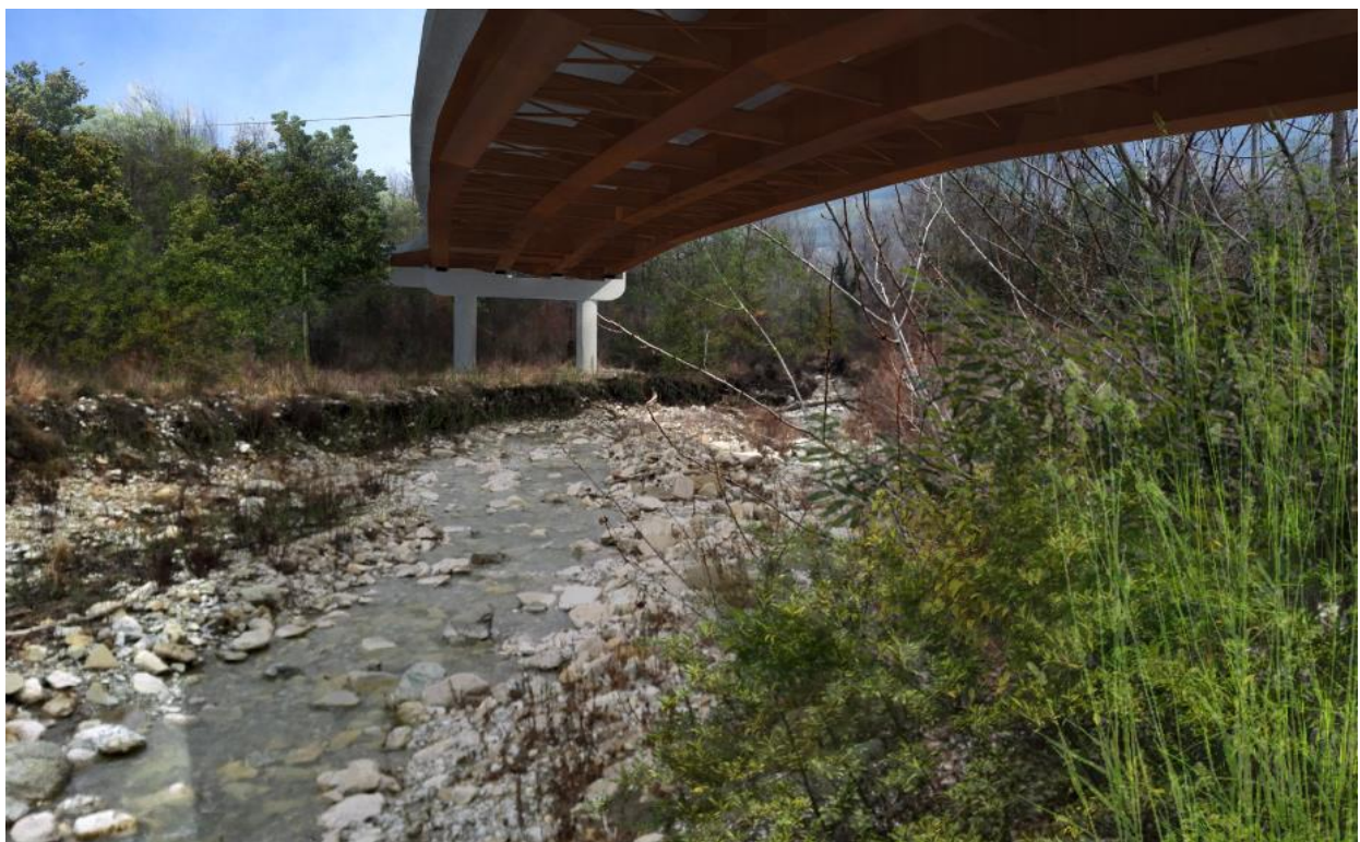
Fotoinserimento 4 – Il Viadotto Cernusca nel tratto di attraversamento dell'alveo del rio
