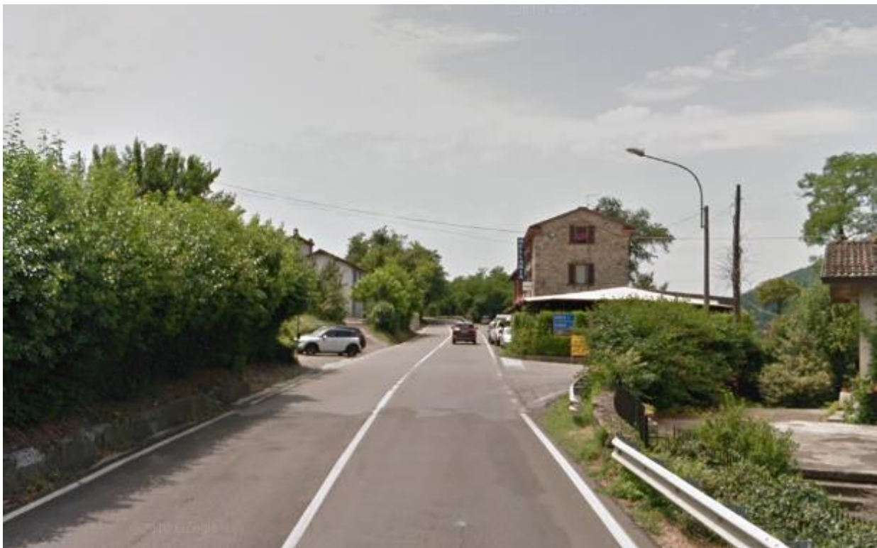
Tratto 1 - Foto 2 – Bivio per Frazione Marchesi - S.P.40
