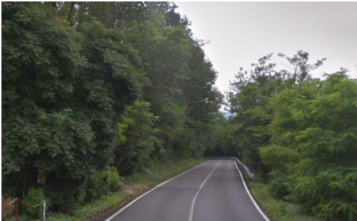
Tratto 7 - Foto 35 – Ambito di realizzazione della rotonda n. 7
