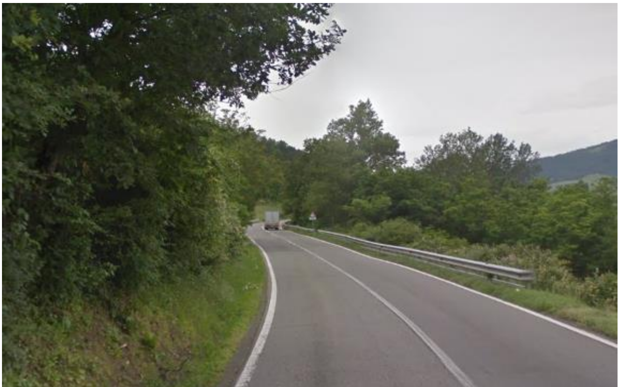
Tratto 7 - Foto 34– S.S. 45 all'altezza del Rio D'Andrea
