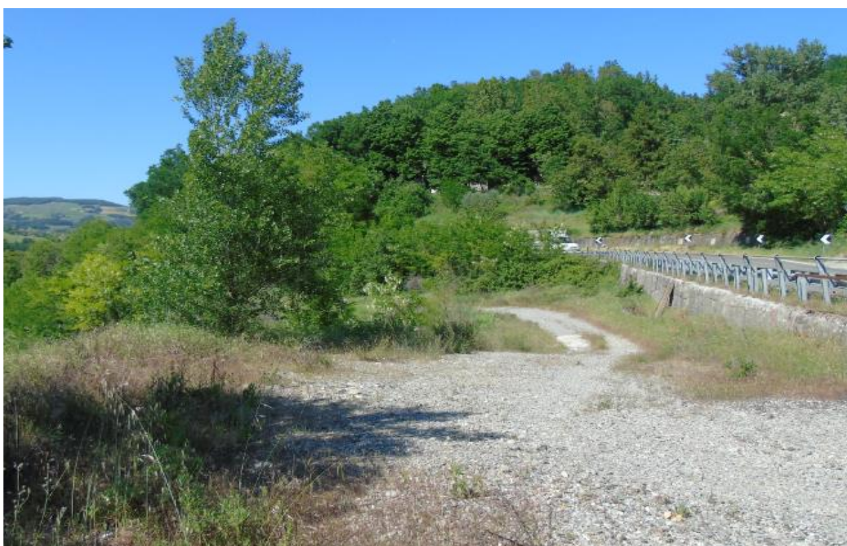
Tratto 8 - Foto 36– Punto di inizio del viadotto Cernusca – Vista direzione nord
