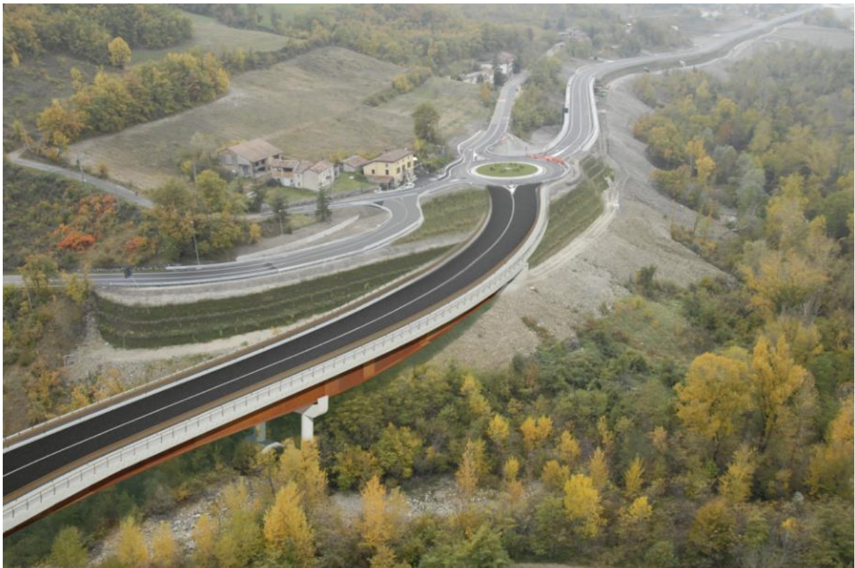
Fotoinserimento 5 – Il Viadotto Cernusca, tratto terminale di raccordo alla rotonda 8, fine intervento
