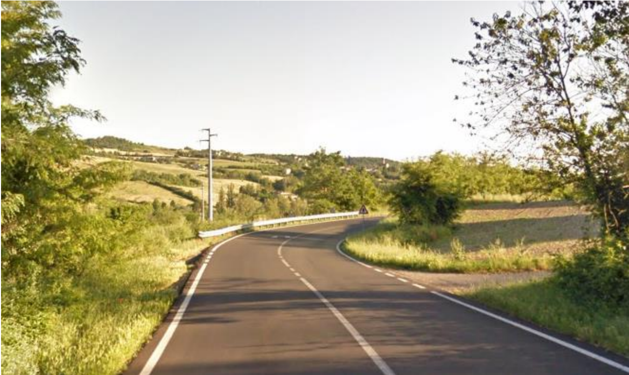
Tratto 1 - Foto 4– Progressiva all’altezza della Cascina Savigliano
