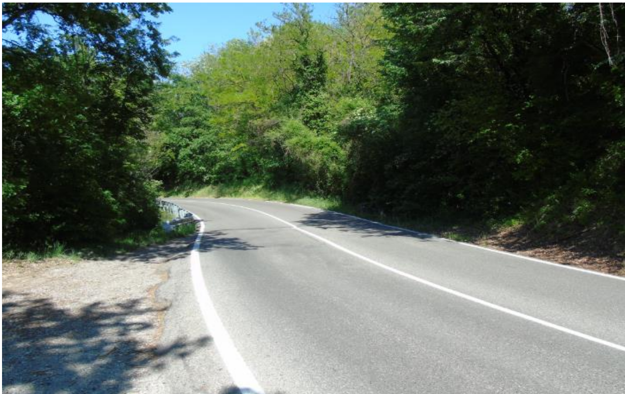
Tratto 6 - Foto 30– S.S.45 all'altezza del Km 111
