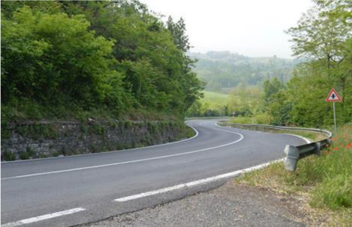
Tratto 1 - Foto 6– S.S. 45, ambito di intervento dopo l'abitato di Fabiano
