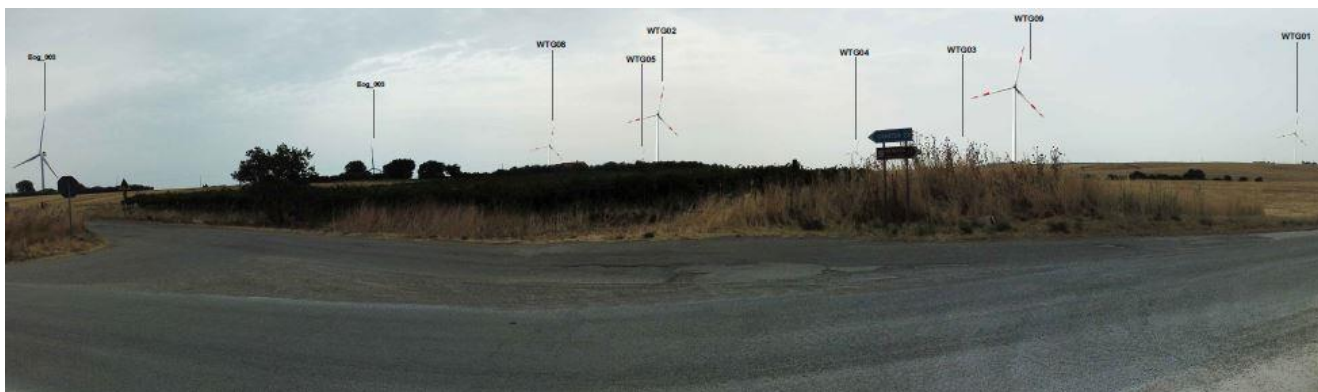
Figura 3-22: Panoramica dalla SP18 Ofantina – post opera
