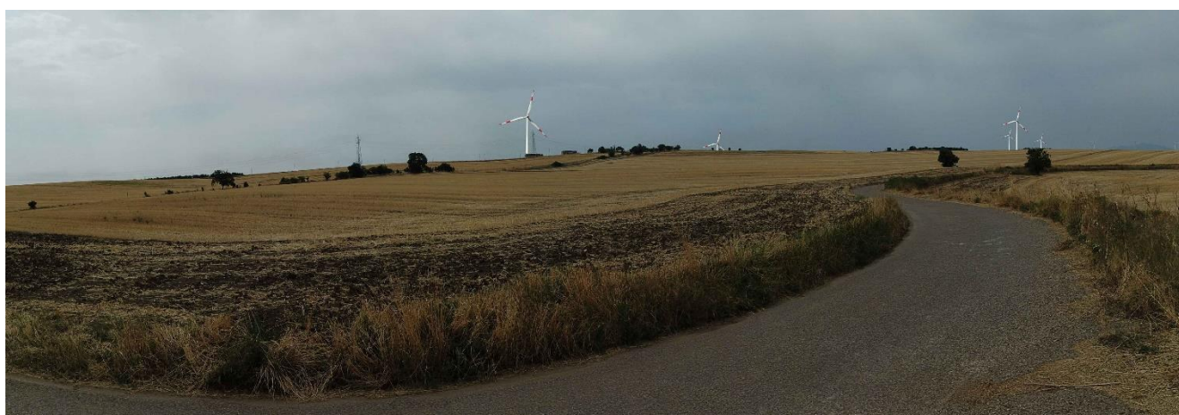
Figura 3-26: Panoramica dalla SP52 – post opera
