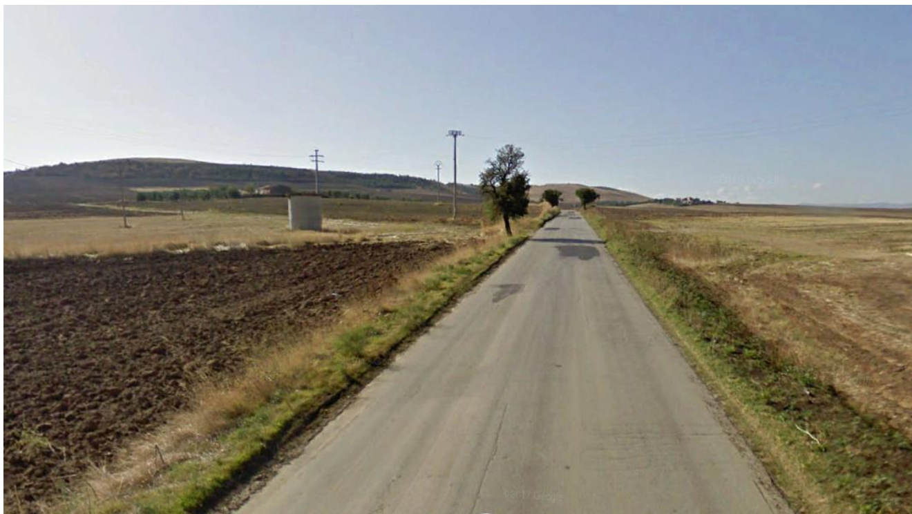
Figura 2-5: SP 18 verso l'area di impianto
