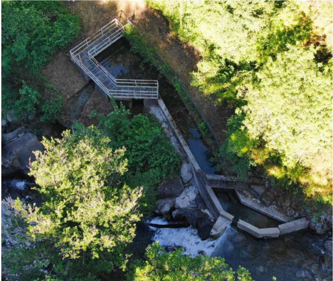
Foto – La vasca di decantazione e compenso da cui parte la condotta in pressione
