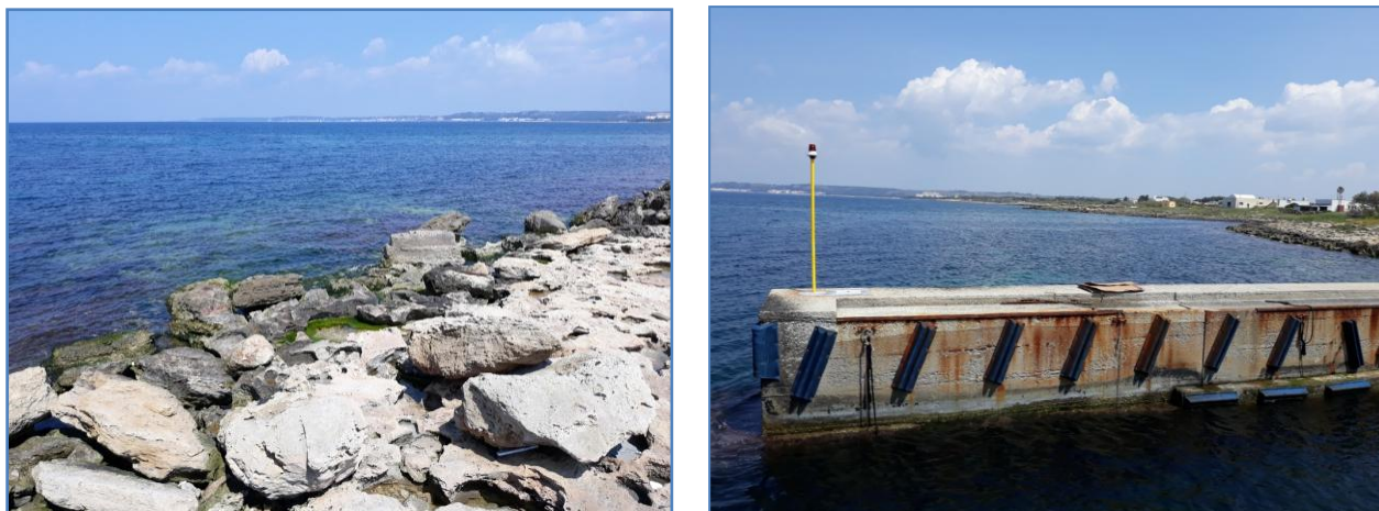
Fig. 4, 5. Porto Gaio - Gallipoli (LE). Area interessata dalle attività di prospezione archeologica subacquea.
