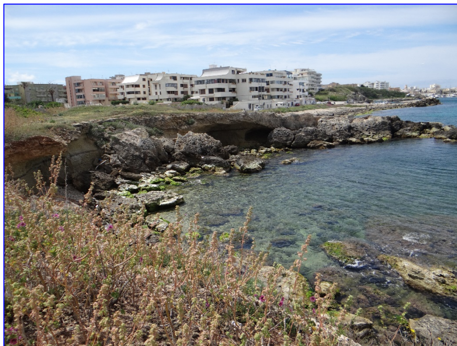
Foto 8 – Morfotipo costiero Falesia (tipo 3) . Il piede della falesia appare modellata nelle sabbie argillose del Pleistocene inferiore riferibili alla Formazione di Gallipoli. Da notare le profonde cavità modellata nella parte inferiore della falesia e la presenza del livello vulcanoclastico di colore scuro.
