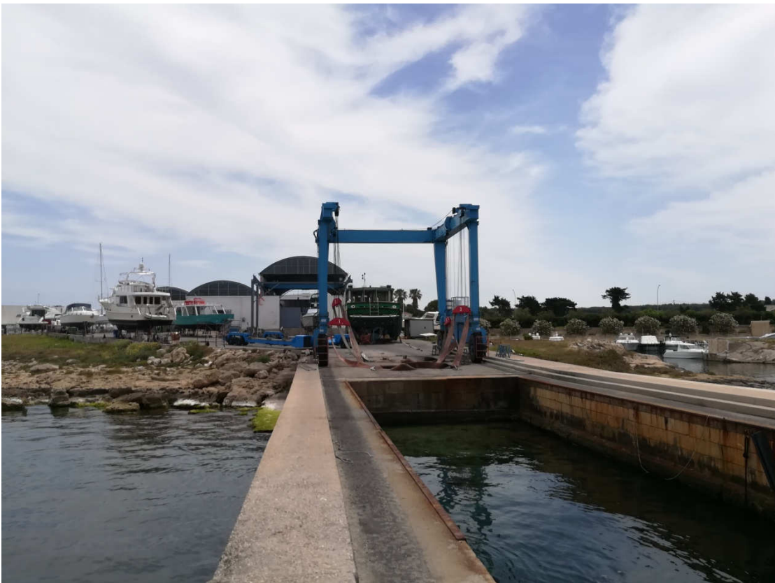
FOTO 16 - SCALO DI ALAGGIO
