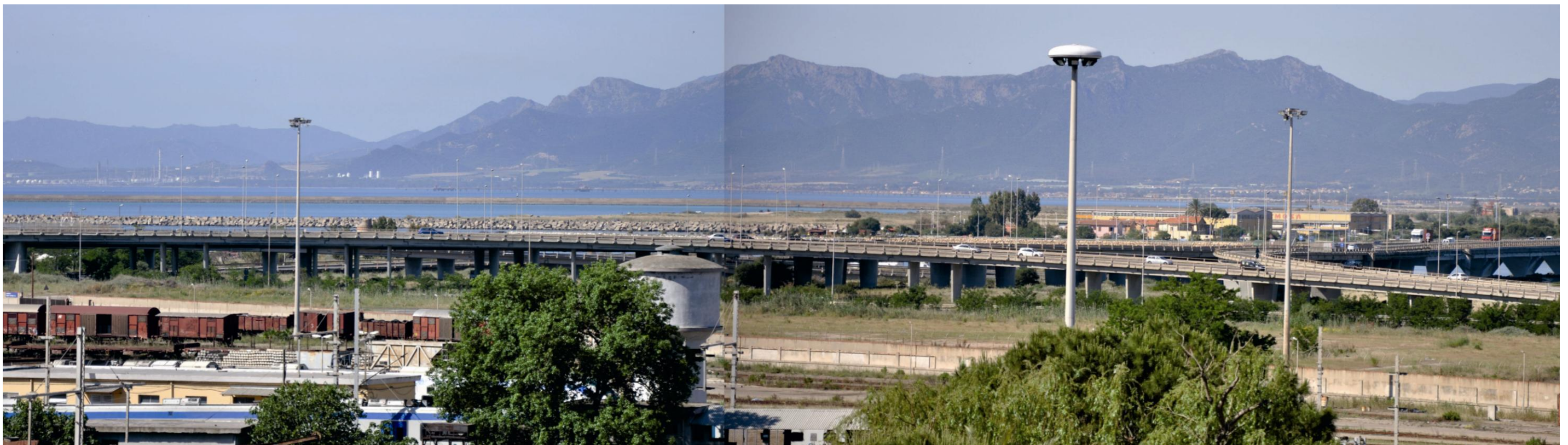
Foto 53 – Vista dell'area di Intervento da via Nazario Sauro
