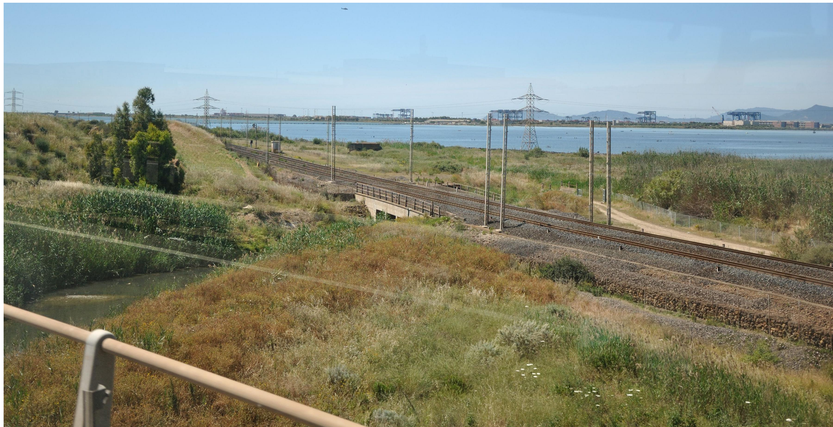
Foto 4 – Vista dal raccordo con la S.S. 195: Laguna di Santa Gilla e area del Porto Canale in cui sono visibili grandi strutture metalliche funzionali alle attività di carico e scarico delle merci dalle navi. In primo piano la linea ferroviaria che costeggia la laguna di Santa Gilla e la linea elettrica
