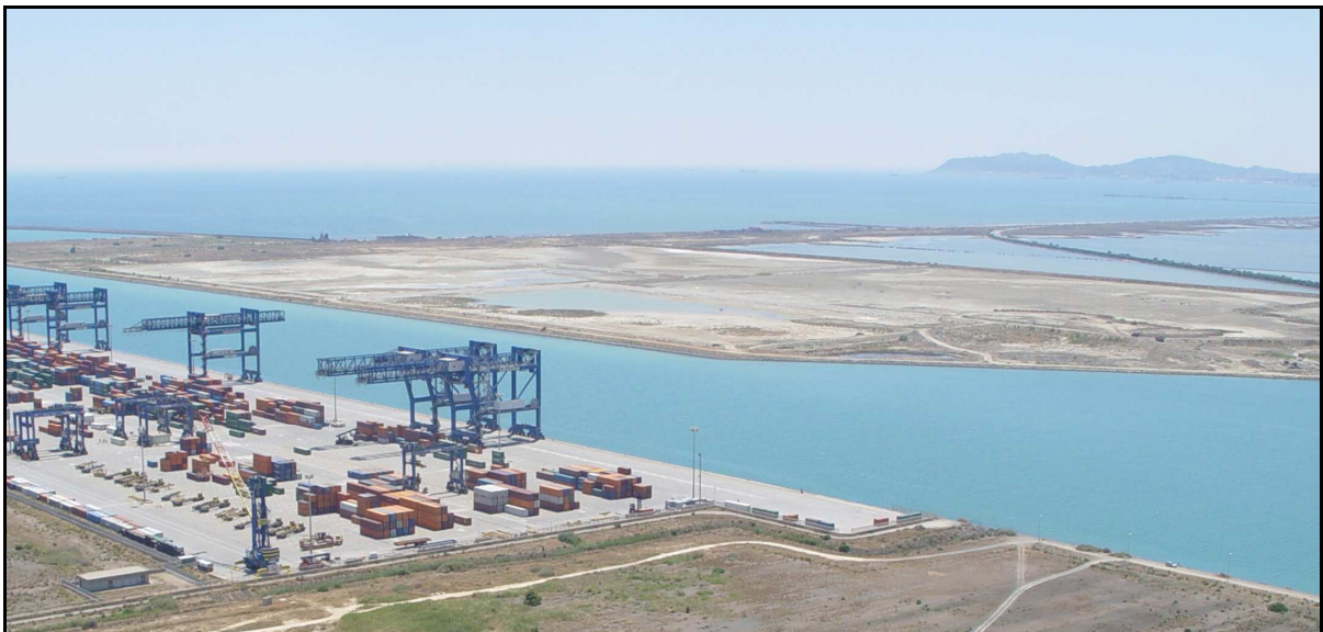
Fig. 10 – Sullo sfondo tutta la colmata
