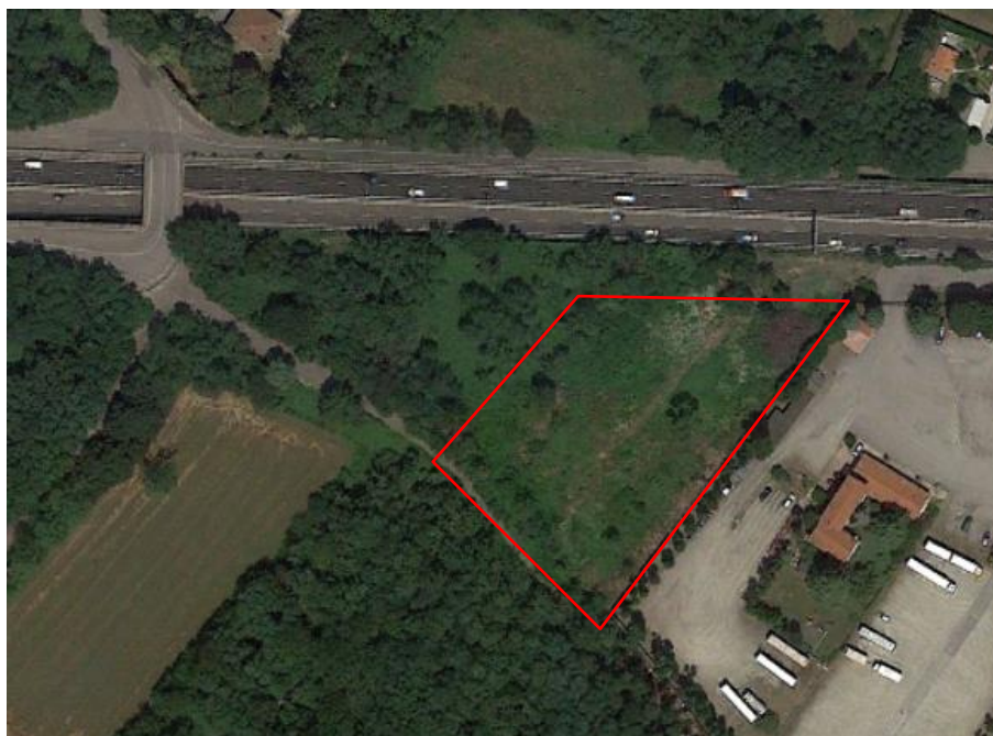
Figura 7 - Area cantiere operativo CO02
