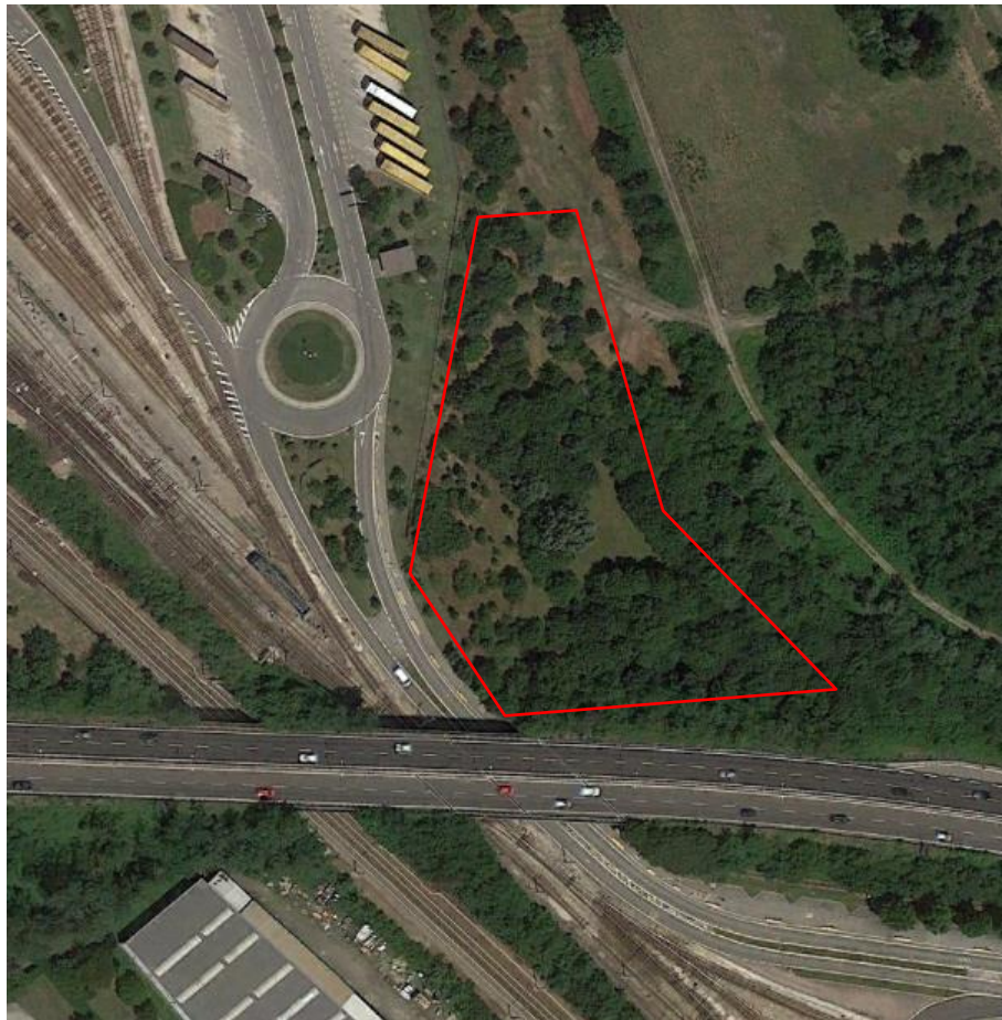
Figura 11 - Area cantiere operativo CO04
