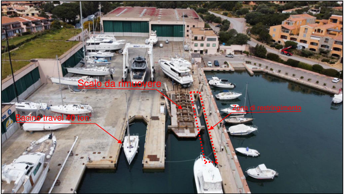
Vista frontale area d'intervento
