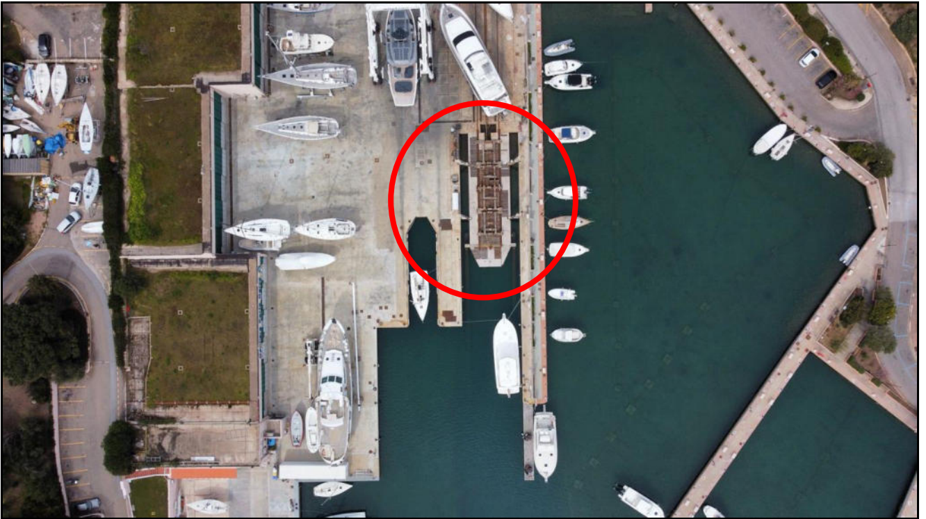
Vista zenitale area intervento
