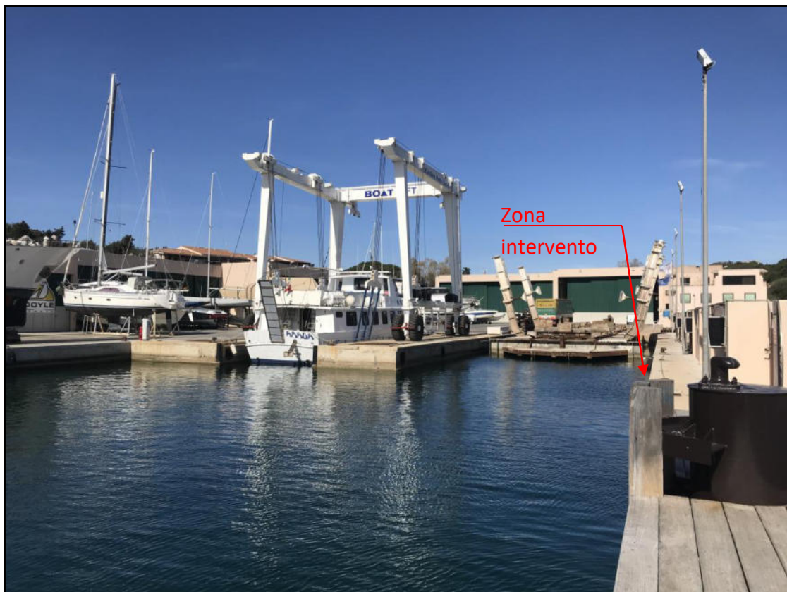
VISTA ZONA DI INTERVENTO BACINO
