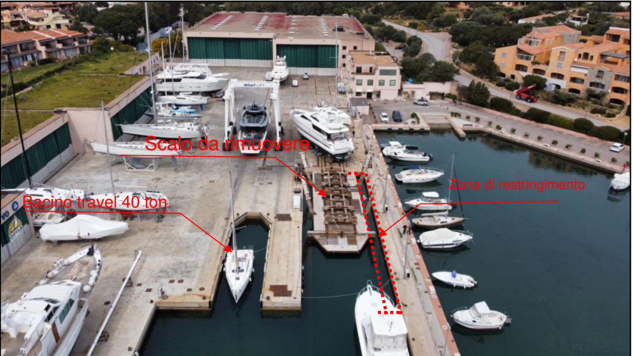
Vista frontale area d'intervento
