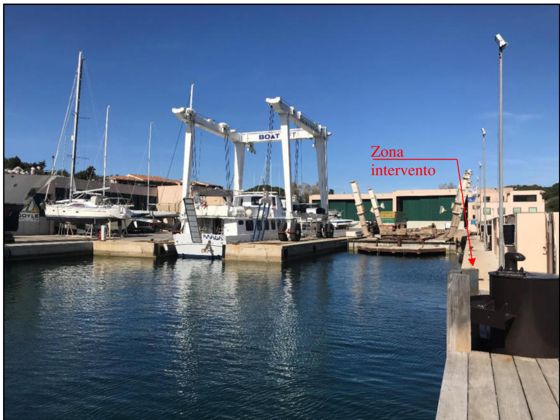
VISTA ZONA DI INTERVENTO BACINO
