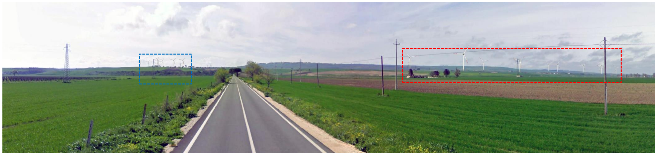
PAN 29 _ Confronto tra stato di fatto (in alto) e progetto _ Vista a circa 2,3 km di distanza dagli aerogeneratori in progetto (nel riquadro rosso) e a sinistra 7 aerogeneratori di recente realizzazione (riquadro blu)
