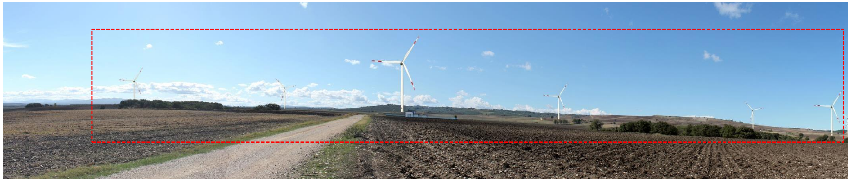
PAN 20_ Confronto tra stato di fatto (in alto) e progetto _ Vista a circa 800 m di distanza dagli aerogeneratori in progetto (nel riquadro rosso)
