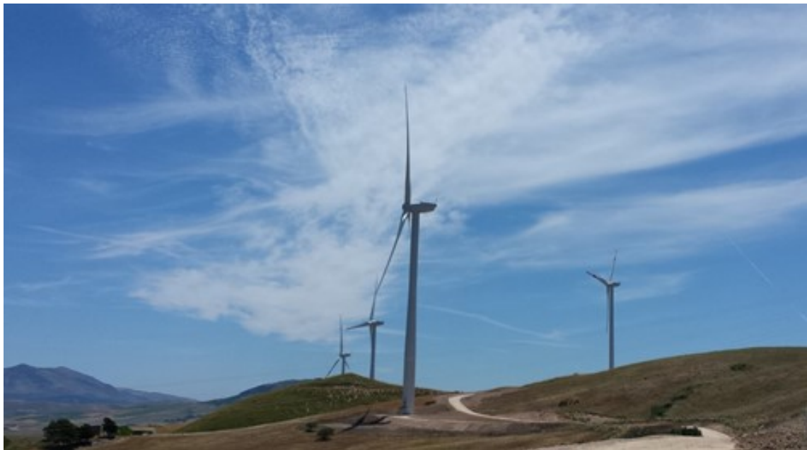
Impianto Eolico di proprietà nel Comune di Buseto Palizzolo (TP) – Impianto in esercizio – si noti la ricostituzione del profilo del suolo post cantiere.
