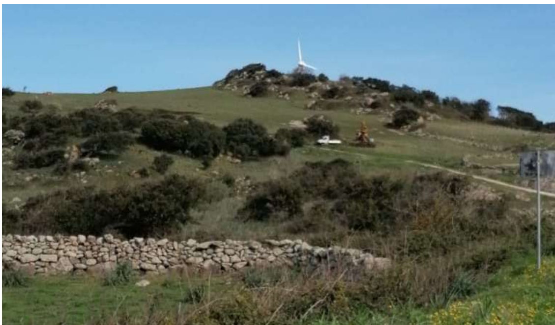
Sito impianto aerogeneratore WTG6
