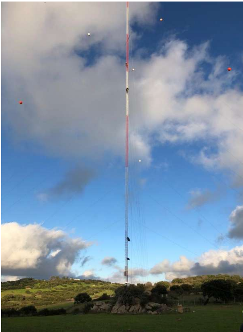
Torre anemometrica installata presso il sito di Ittiri
