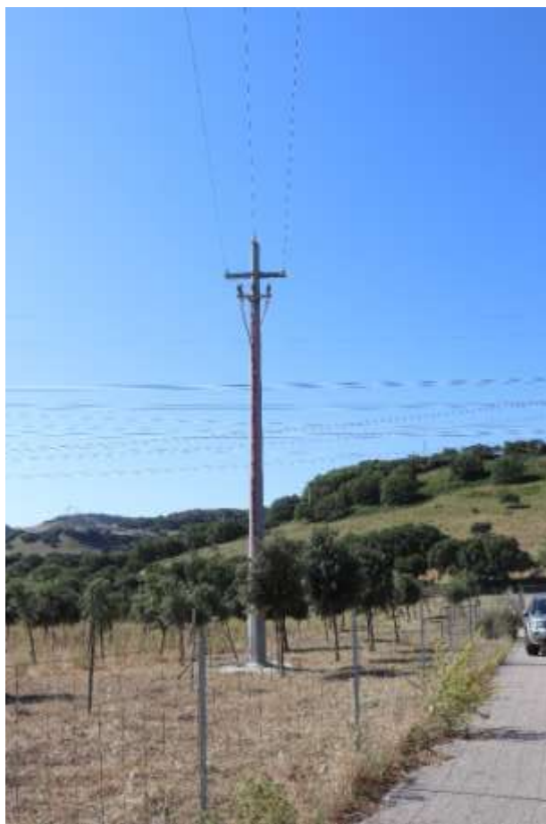
Sostegno e linea MT e, in secondo piano, linee aeree ad altissima tensione nei pressi della strada di accesso della SE RTN 380 kV “Ittiri”
