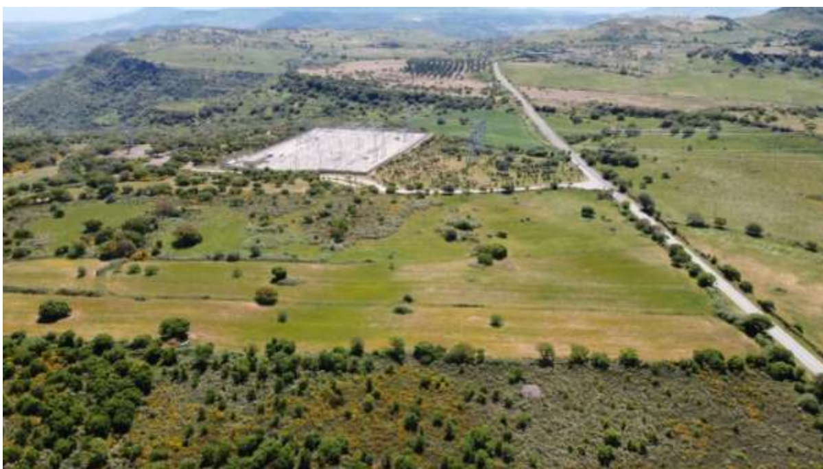
Area di ampliamento della stazione elettrica Terna e della sottostazione utente. Punto ripresa DJI0114
