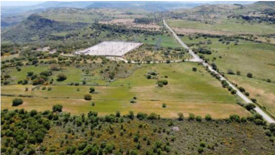
Area di ampliamento della stazione elettrica Terna e della sottostazione utente. Punto ripresa DJI0114
