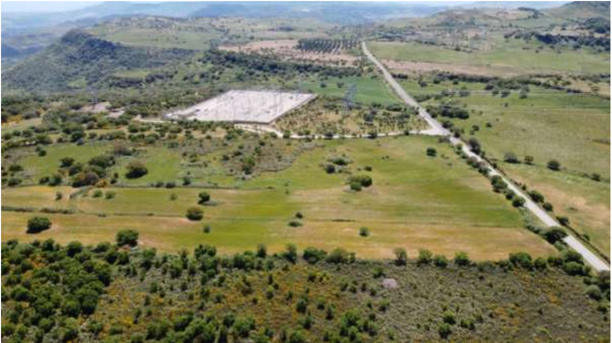
Area di ampliamento della stazione elettrica Terna e della sottostazione utente. Punto ripresa DJI0114
