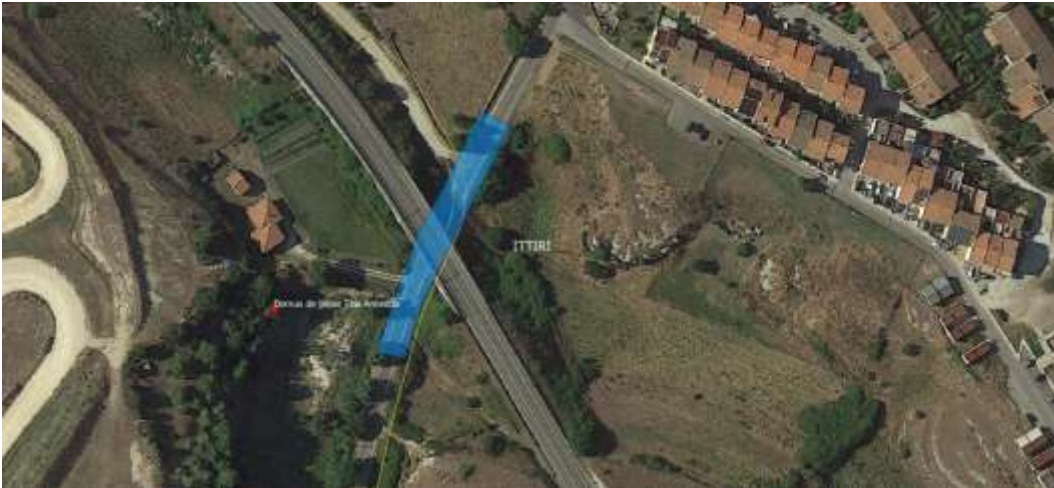
Sottopassaggio all'uscita del centro abitato di Ittiri. Grado di rischio medio.
