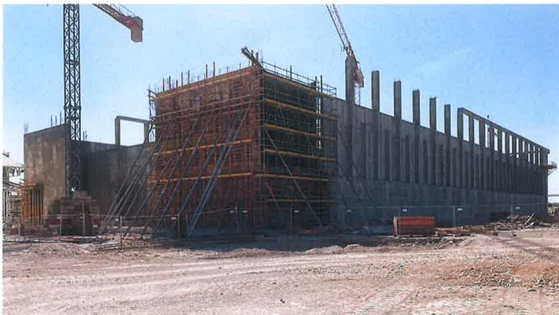
**Figura 10 – Capannone stoccaggio idrato di alluminio e fluorite in corso di realizzazione**
