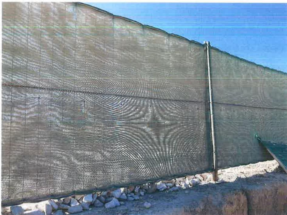
**Figura 3 - Barriera frangivento per il confinamento delle polveri**
