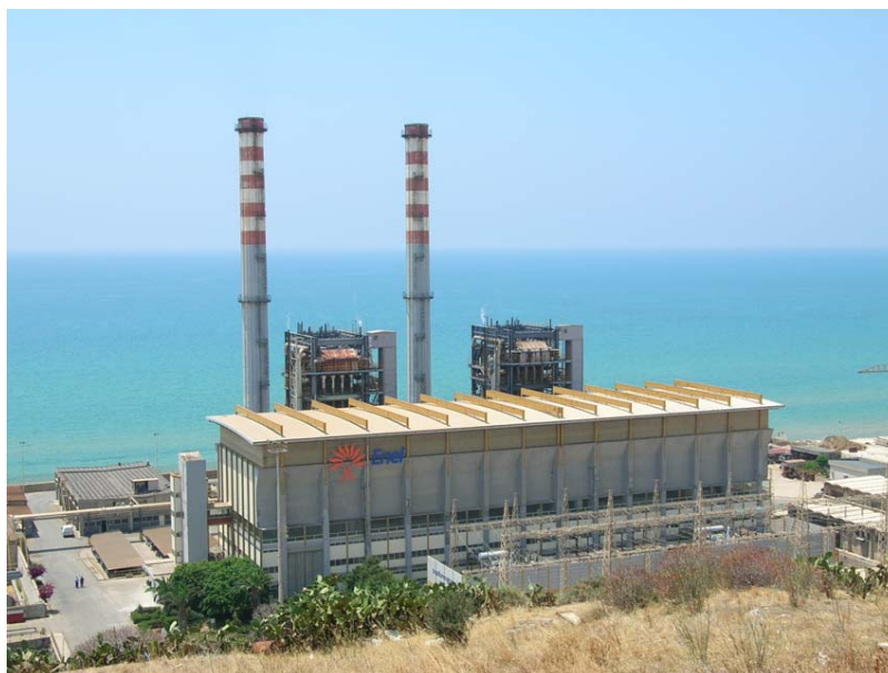
Figura 1-1 Centrale di Porto Empedocle – Assetto attuale
