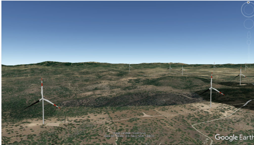
Vista Aerogeneratori BE01 – BE02 – BE03 (in primo piano)
