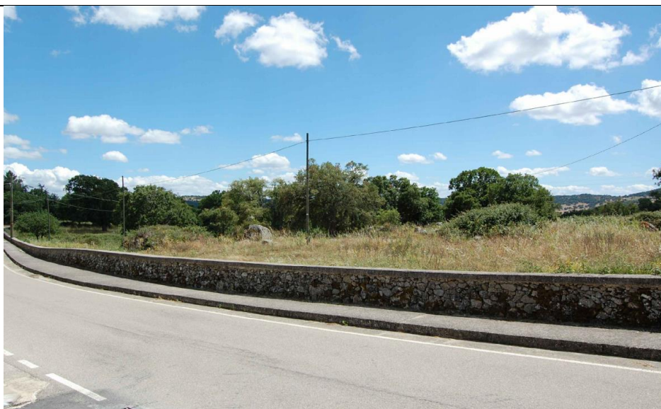
Figura 58: Stato di fatto del F4
