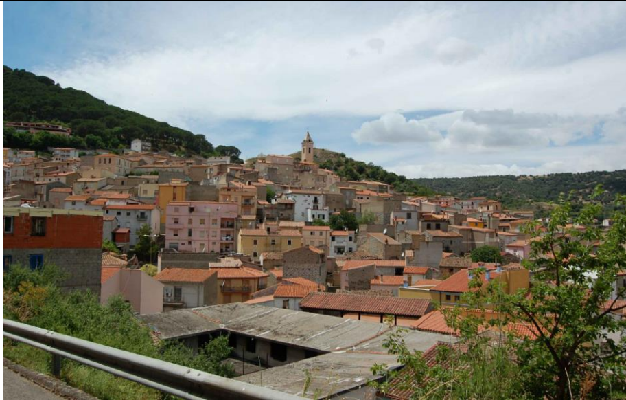
Figura 60: Stato di fatto del F5
