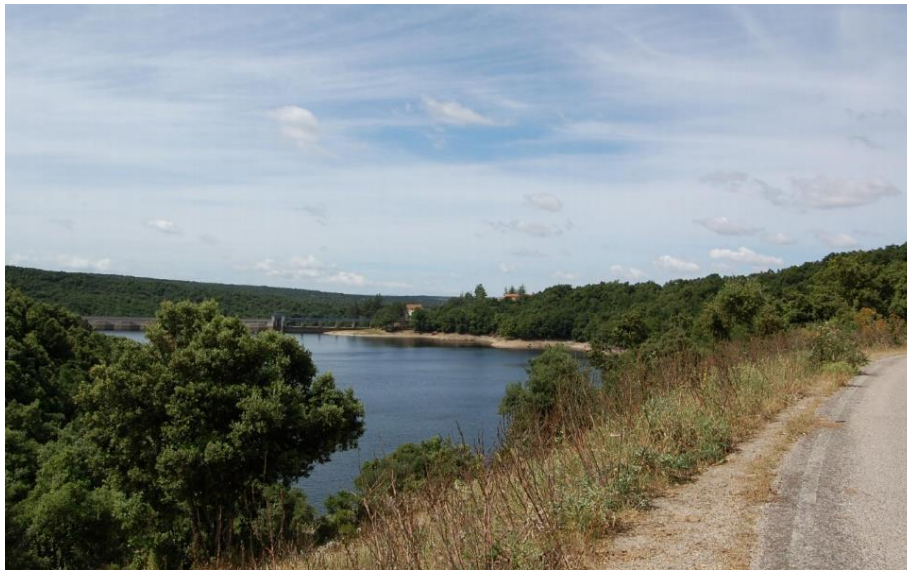
Figura 52: Stato di fatto del F1
