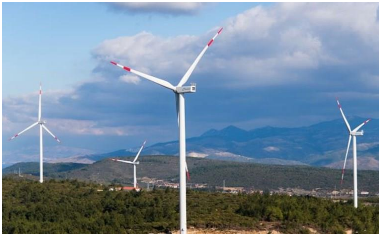
Figura 6: Impianto eolico tipo esistente (Aerogeneratori Nordex)
