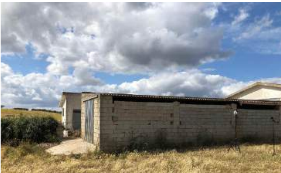
Figura 9: Dettaglio posizione microfono e centralina meteo
