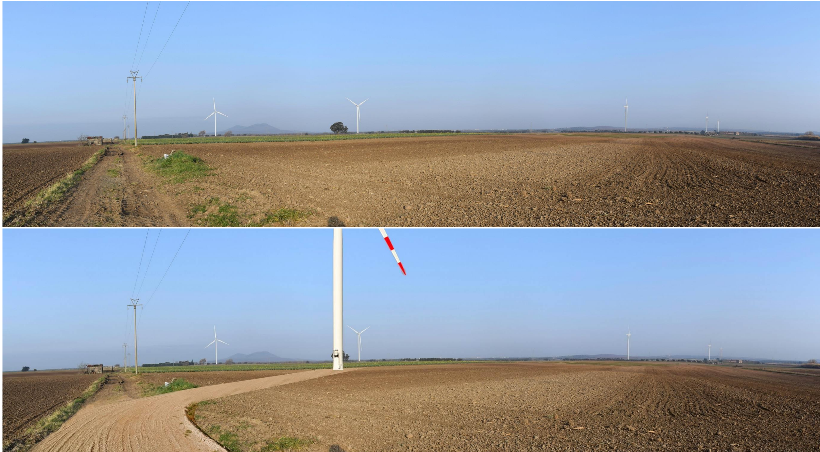
Figura 36 Panoramica 18 _ Vista dalla strada comunale che attraversa il Sottocampo Ovest composto da 6 WTG, a 200 m dalla WTG A06 Nell'immagine in alto, lo stato di fatto con gli aerogeneratori ricadenti in comune di Tessennano e Arlena di castro. Nell'immagine in basso, fotoinserimento verso la WTG A06 con la tipologia utilizzata per la viabilità di servizio.
