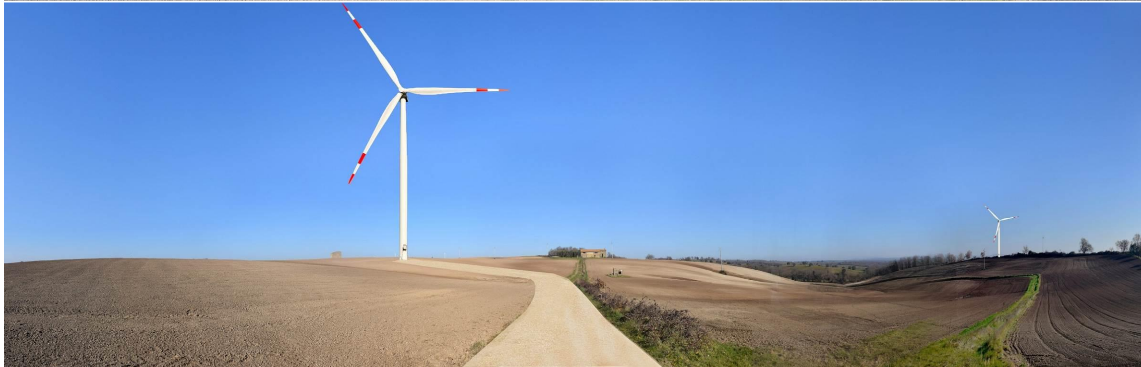
Figura 37 Panoramica 19 _ Vista dalla strada comunale che attraversa il Sottocampo Nord composto da 10 WTG, a 250 m dalla WTG A14 Nell'immagine in alto, lo stato di fatto. Nell'immagine in basso, fotoinserimento verso le WTG A14 (a sinistra) e A15, con in evidenza la tipologia utilizzata per la viabilità di servizio
