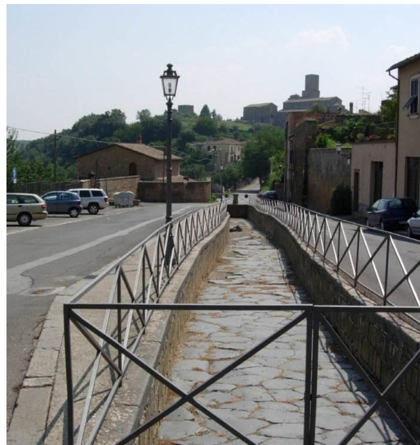
Figura 8 In alto, la Via Clodia (in magenta) tra la Via Aurelia (in blu) e la Via Cassia (in rosso); in basso, resti della Via Clodia a Toscana.
