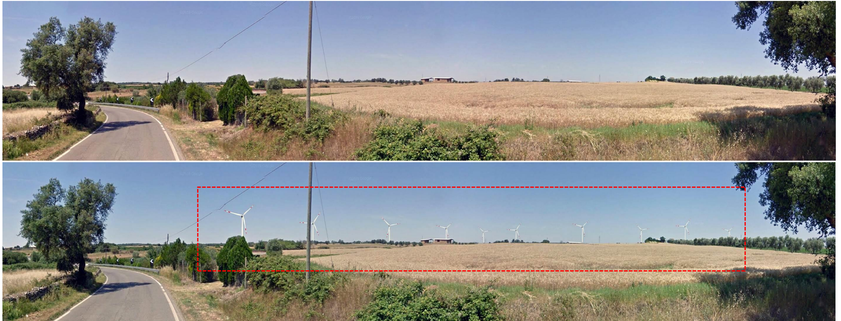
Figura 6 Panoramica 07 _ Vista dalla SP 12, procedendo da Marta verso Tuscania, a 1,6 km dall'impianto (Sottocampo Nord composto da 10 WTG). Da questo punto di visuale, è possibile osservare la regolare disposizione degli aerogeneratori in progetto e soprattutto le elevate interdistanze che garantiscono la netta percezione degli elementi caratteristici dell'intorno.
