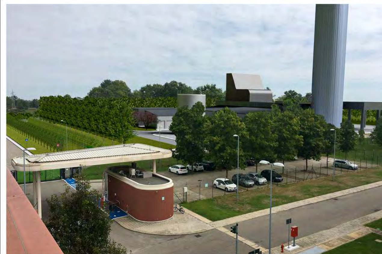
Vista del nuovo impianto dall'ingresso della centrale esistente
