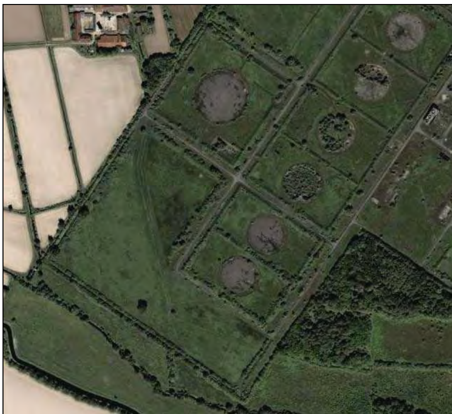
Fig.1 – Foto da satellite con vista dall'alto dell'area destinata alla costruzione della Centrale a Ciclo Combinato situata nel comune di Turano Lodigiano in provincia di Lodi
