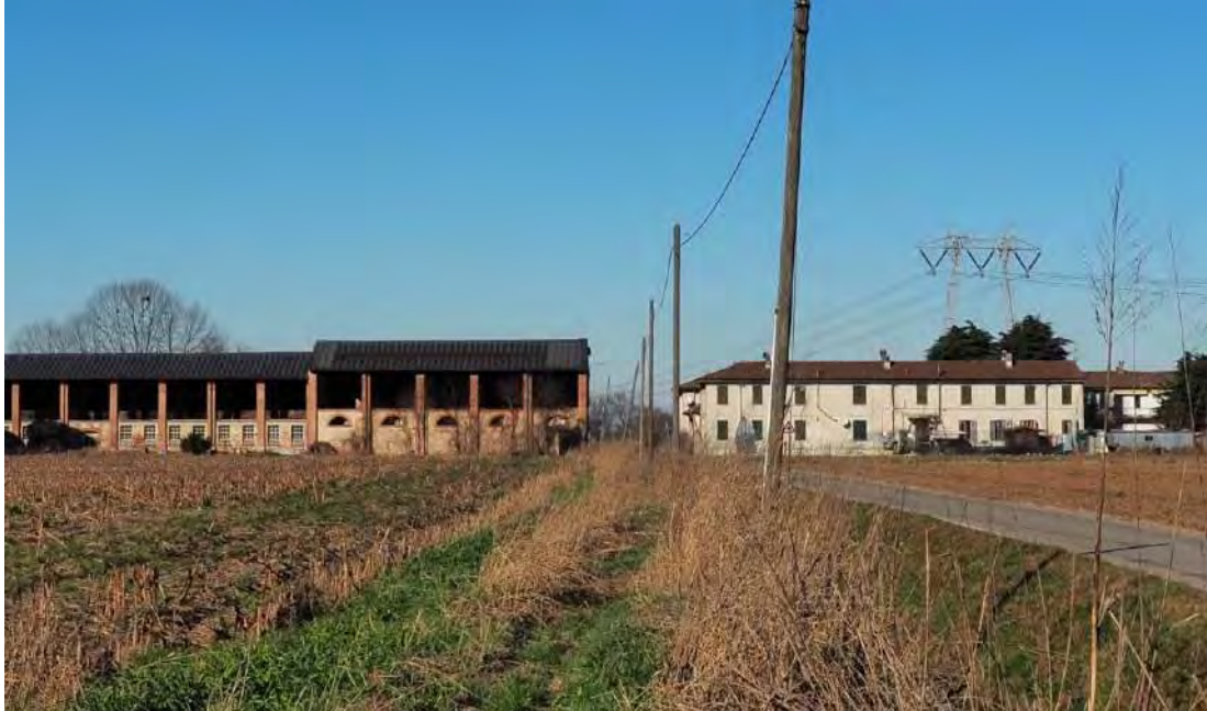
Figura 4-36: Vista d'insieme del complesso con i corpi più recenti sulla destra
