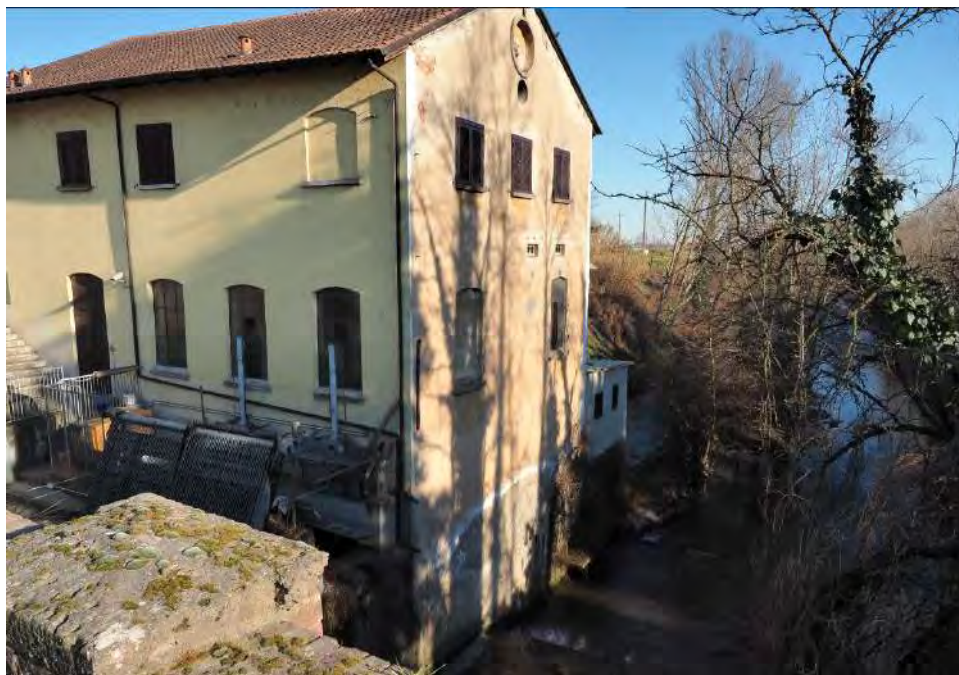
Figura 4-59. Centrale idroelettrica Colombina (Bertonico)
