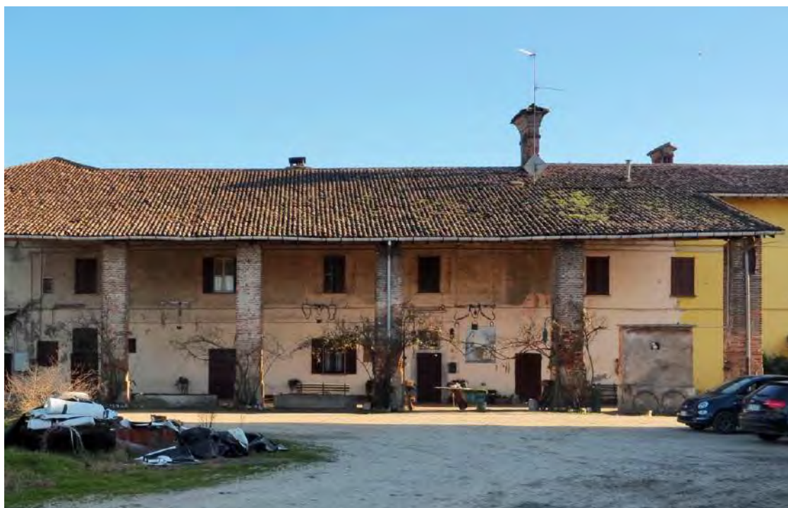
Figura 4-17: Stato attuale della casa del fittabile.
