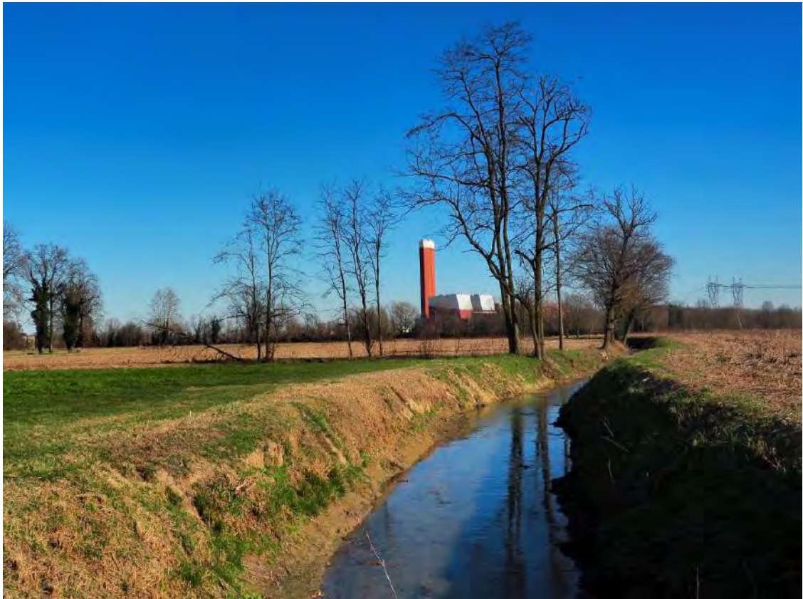
Figura 4-63: Scorcio del Colatore Valguercia, fotografato dalla SP 222. Sullo sfondo la CTE Sorgenia Power vista da NO (vista invernale)
