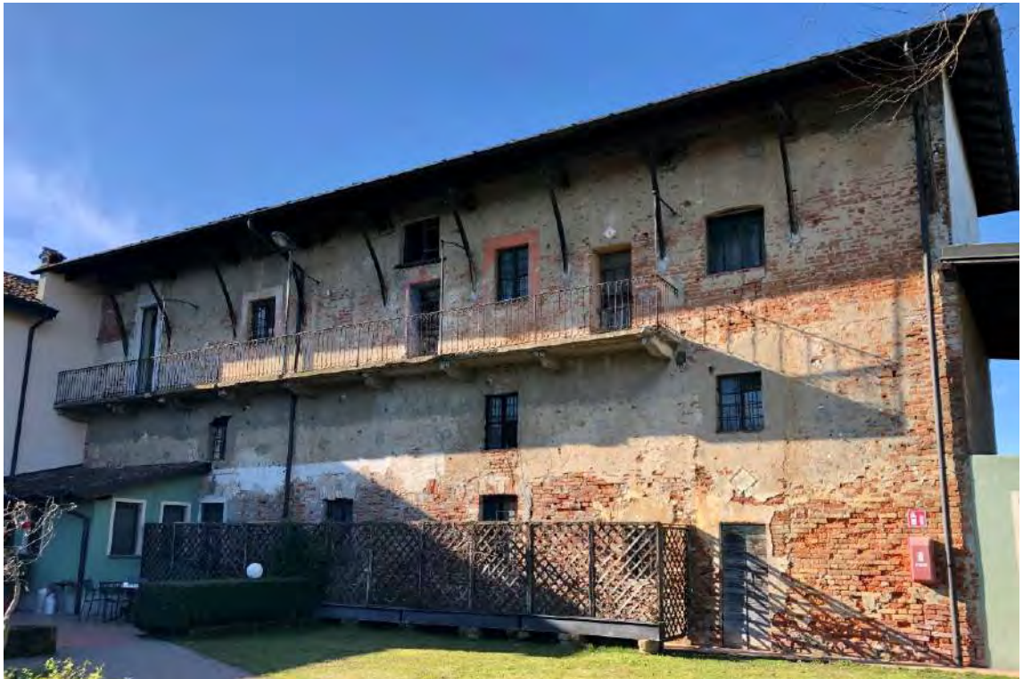
Figura 4-21: Porzione di casa d'abitazione (NE) attualmente in disuso a Cascina Colombina.
