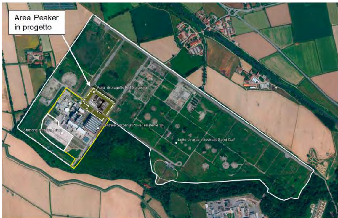
Figura 1-3: Localizzazione dell'Impianto in progetto all'interno del Comparto nord dell'area ex Sarni
