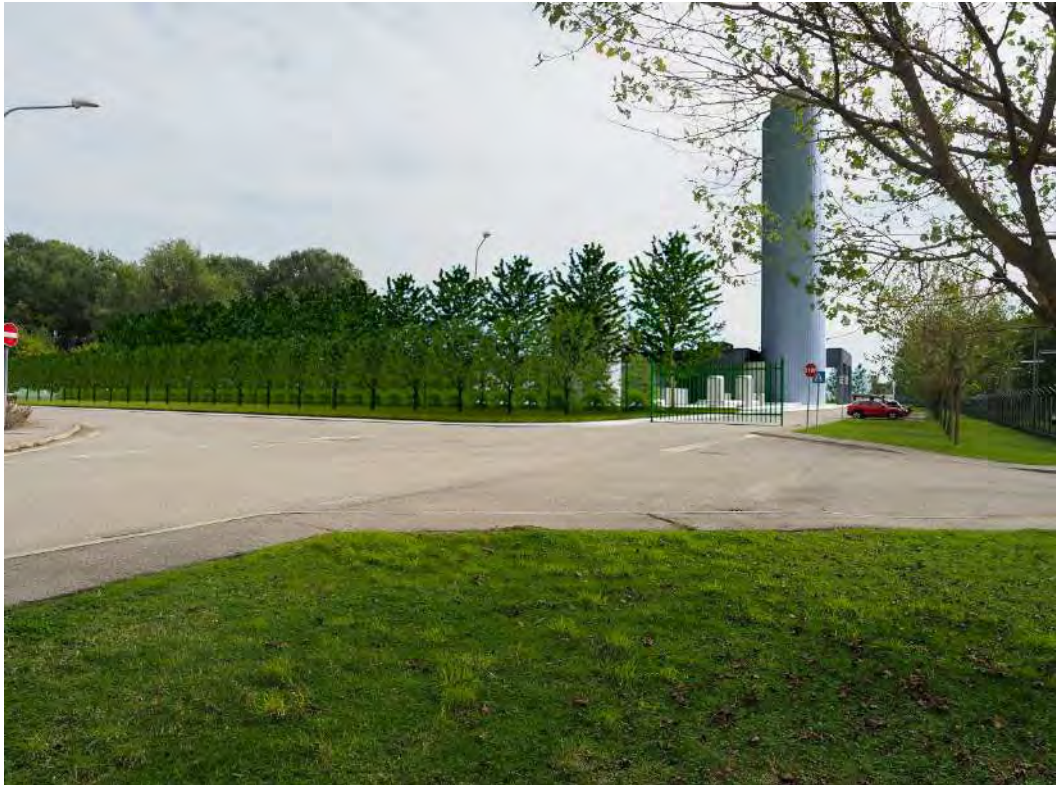
Figura 4-88: Fotoinserimento del nuovo impianto dall'ingresso della CTE Sorgenia esistente
