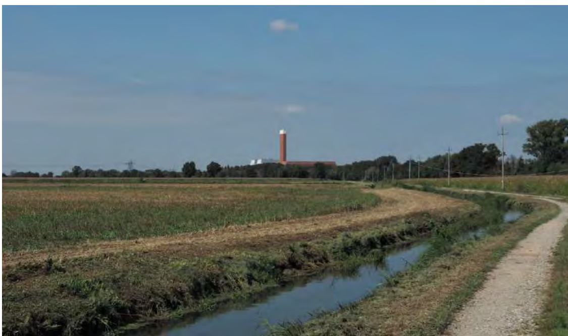
Figura 4-72: Vista della Centrale Sorgenia Power da Sud-Est
