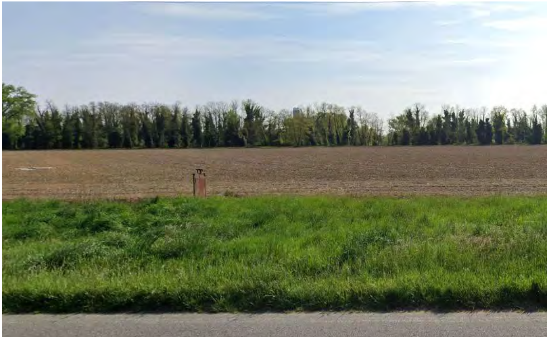
Figura 4-62. Vista dalla SP 26, a N dell'area di progetto, della fascia boscata lungo il canale Muzza: si intravede al centro il camino (h 100 m) della CTE Sorgenia.
