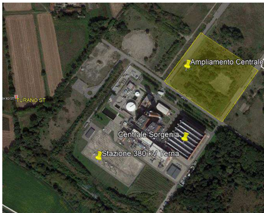
Fig.2 – Ortofoto Centrale Sorghena con ampliamento e stazione Terna
