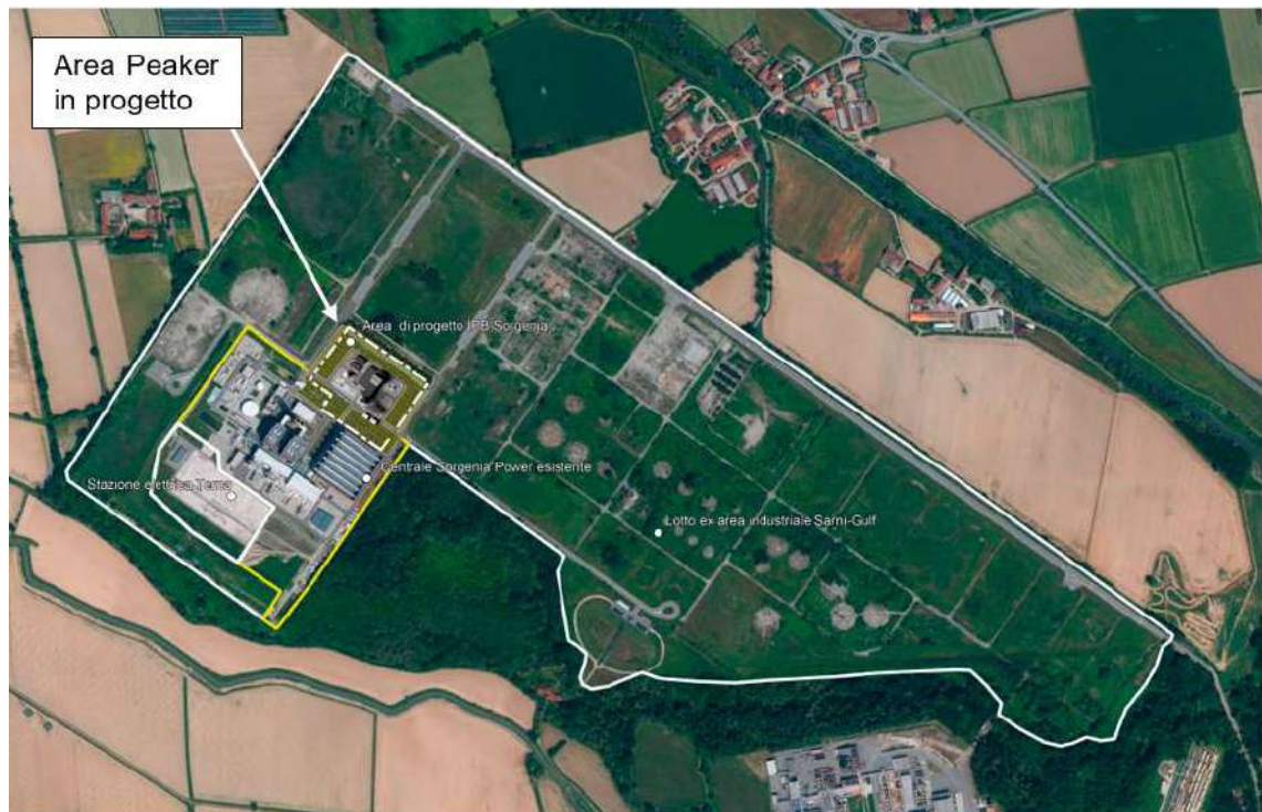
Figura 3: Localizzazione della Centrale all'interno dell'area industriale ex Sarni- Gulf in adiacenza alla Centrale esistente
