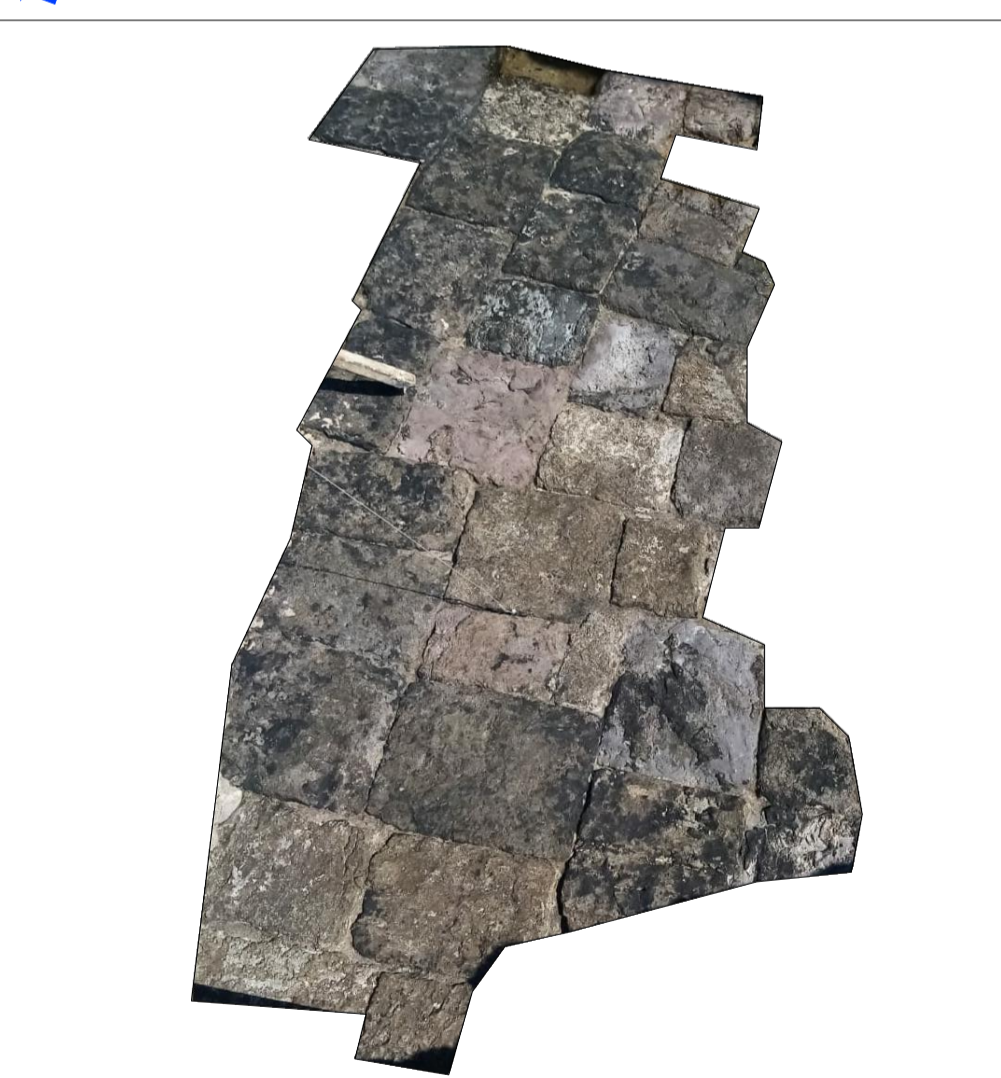
1 DETTAGLIO TIPOLOGICO: Materiale di rivestimento del calpestio dell'opera a mare
