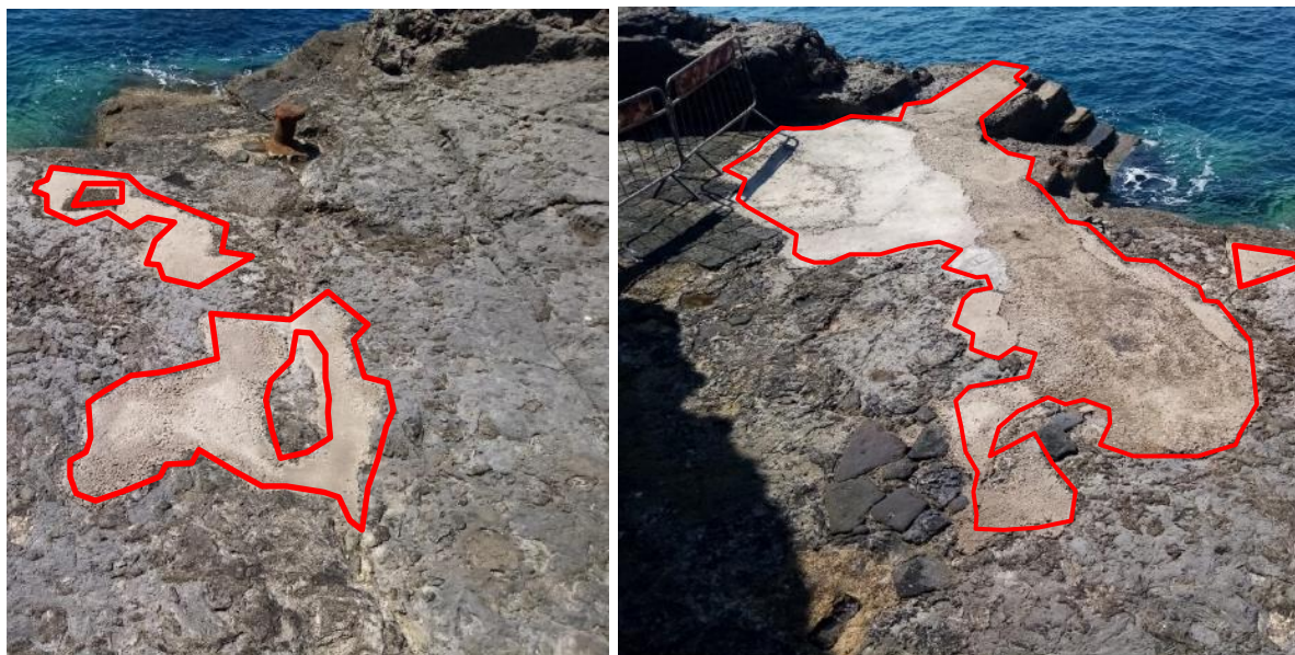
Figura 49. Eliminazione inserti in cls sulla scogliera
