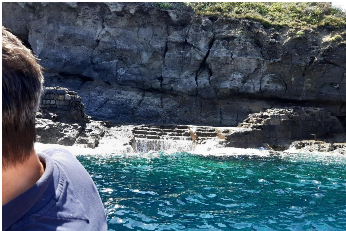
Figura 36. Vista da mare, condizione ante operam
