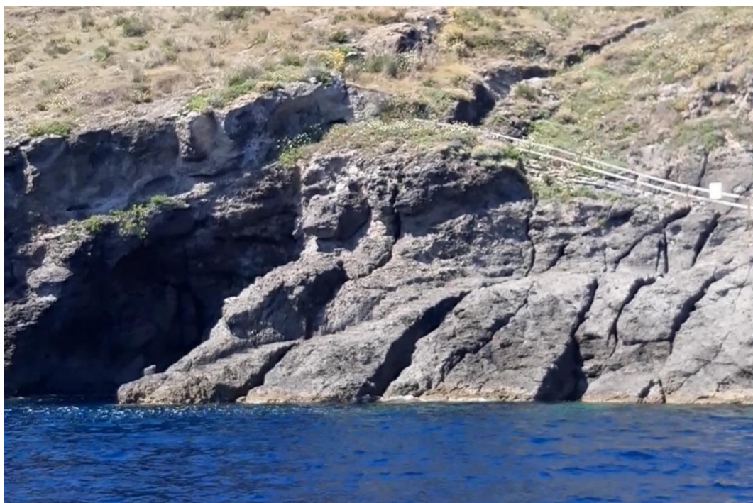
Figura 54. Vista da mare, condizione ante operam
