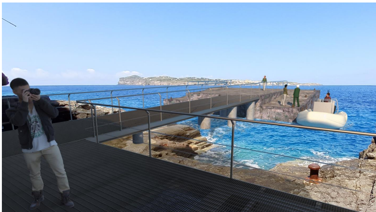
Figura 39. Vista dalla scogliera post operam , Nuovo percorso sopraelevato
