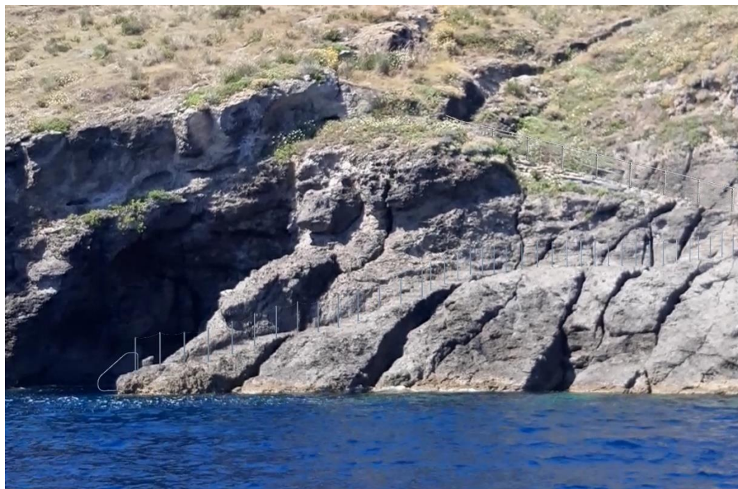
Figura 55. Vista da mare, condizione post operam
