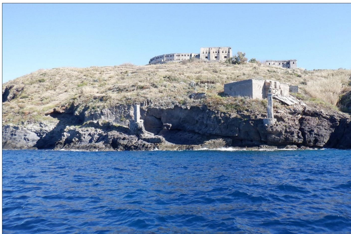
Figura 33. Vista da mare, condizione ante operam
