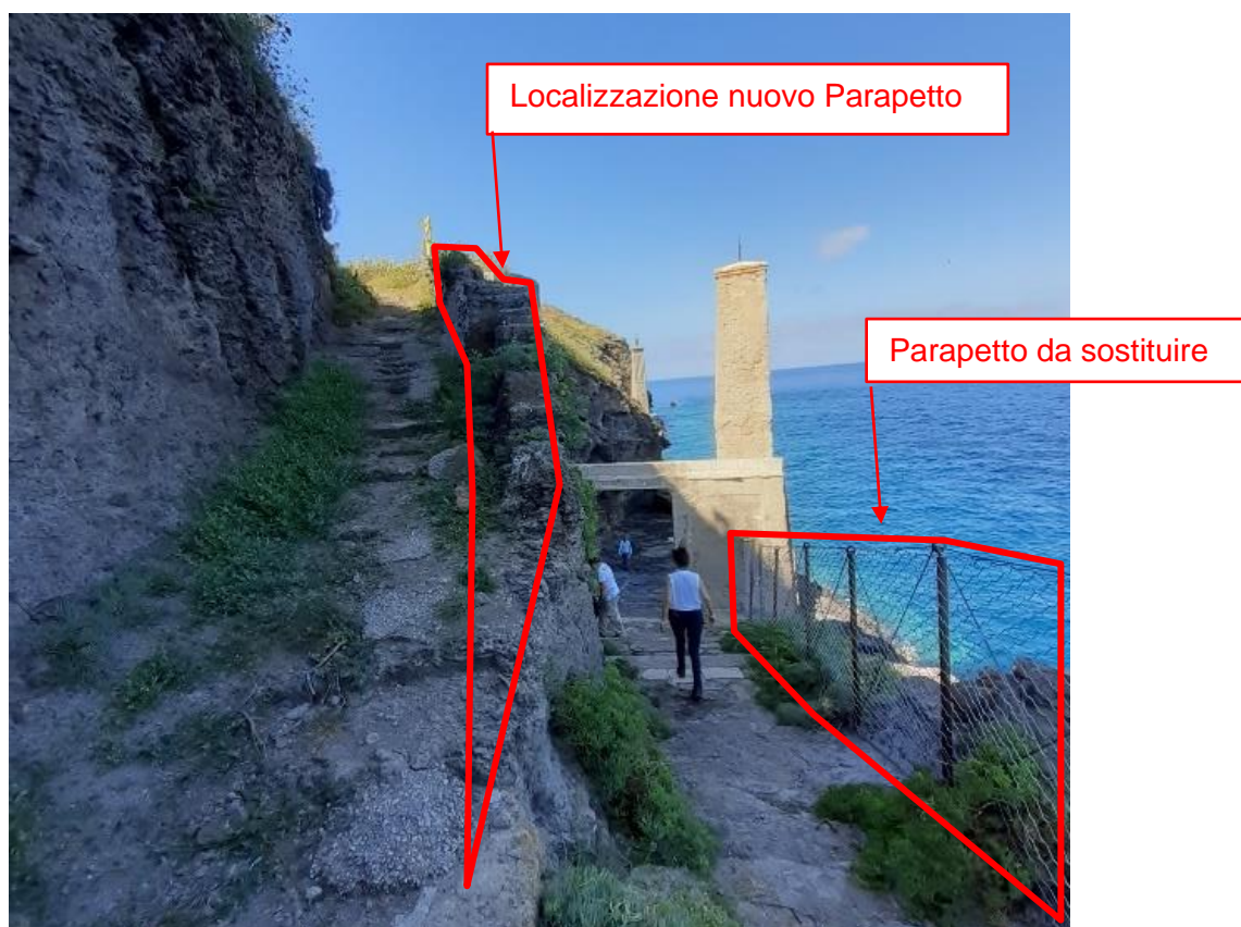
Figura 44. Ripristino localizzato delle pavimentazioni, pulizia sfalco e sostituzione e/o realizzazione nuovi parapetti
