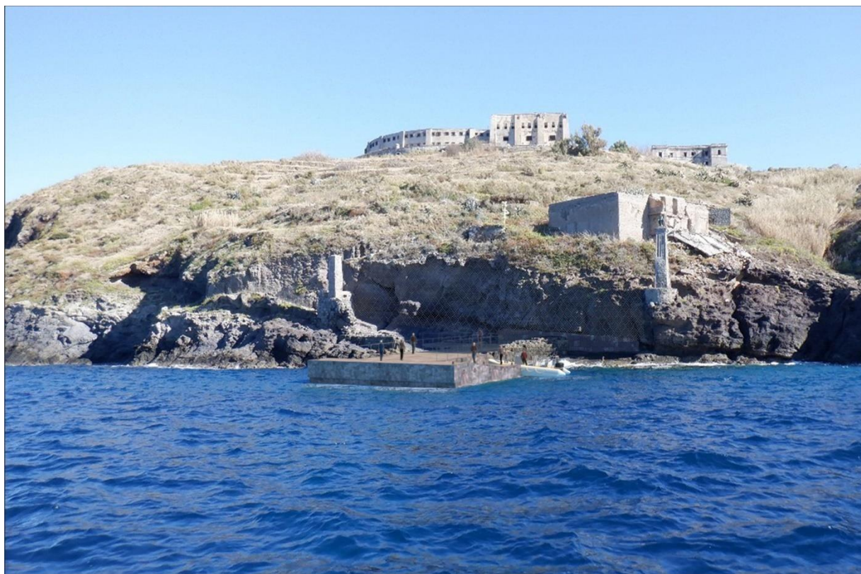
Figura 34. Vista da mare, condizione post operam
