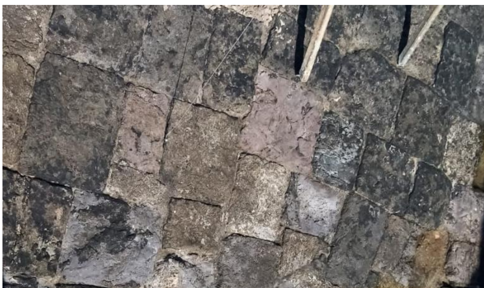
Figura 41. Dettaglio tipologico: materiale di rivestimento del calpestio dell'opera a mare secondo tratto
