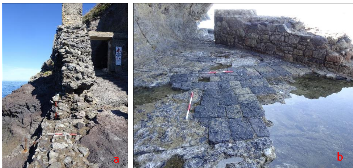
Figura 16 – Il muro che costeggia la via d'accesso al carcere (a) e resti di pavimentazione nel punto dell'approdo (b)
