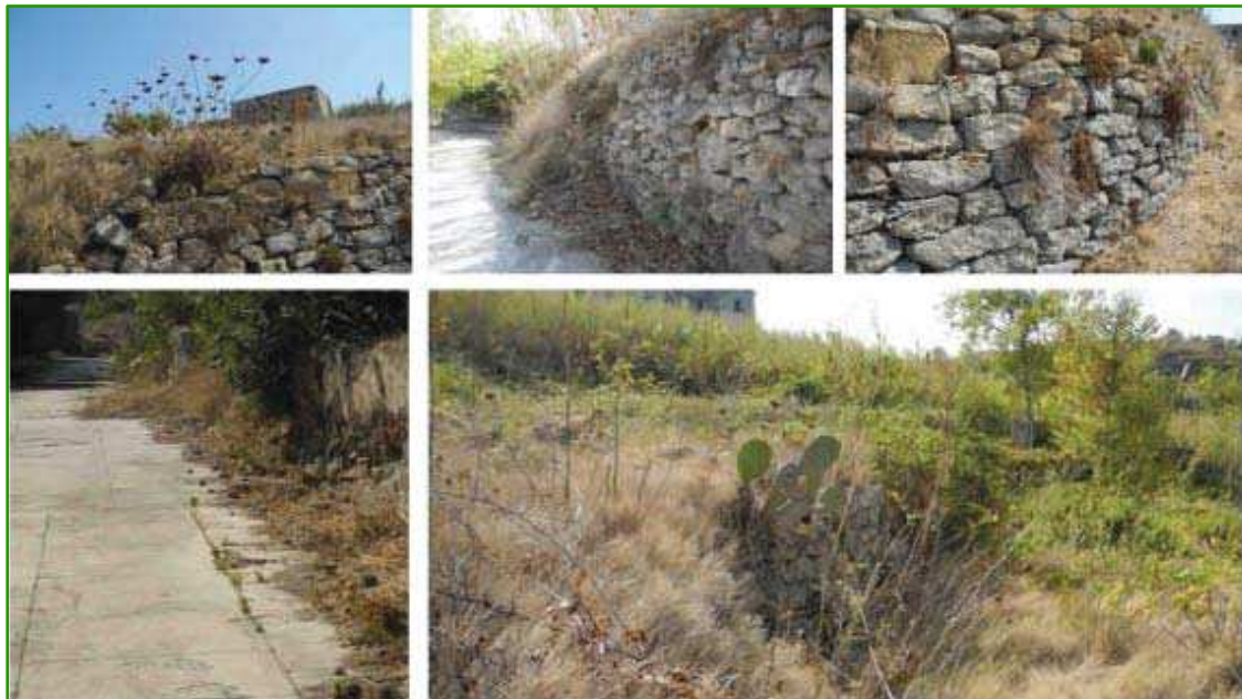
Fig. 18 – Stato di conservazione dei muretti a secco lungo i percorsi di accesso al carcere e al cimitero
