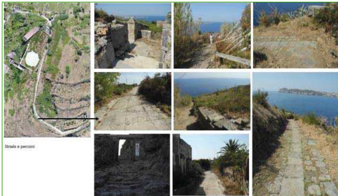
Fig. 17 – Diversità delle caratteristiche costruttive delle strade comunali
