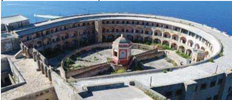
Foto 2 – Vista a volo dello stato dei luoghi (al secondo livello la pensilina in c.a. da demolire)
